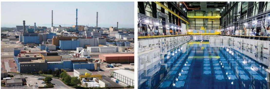
**Figure 3 – Photographies des usines de La Hague (UP2-800 et UP3) et de la piscine d'entreposage des assemblages de combustibles usés en attente de retraitement.**
