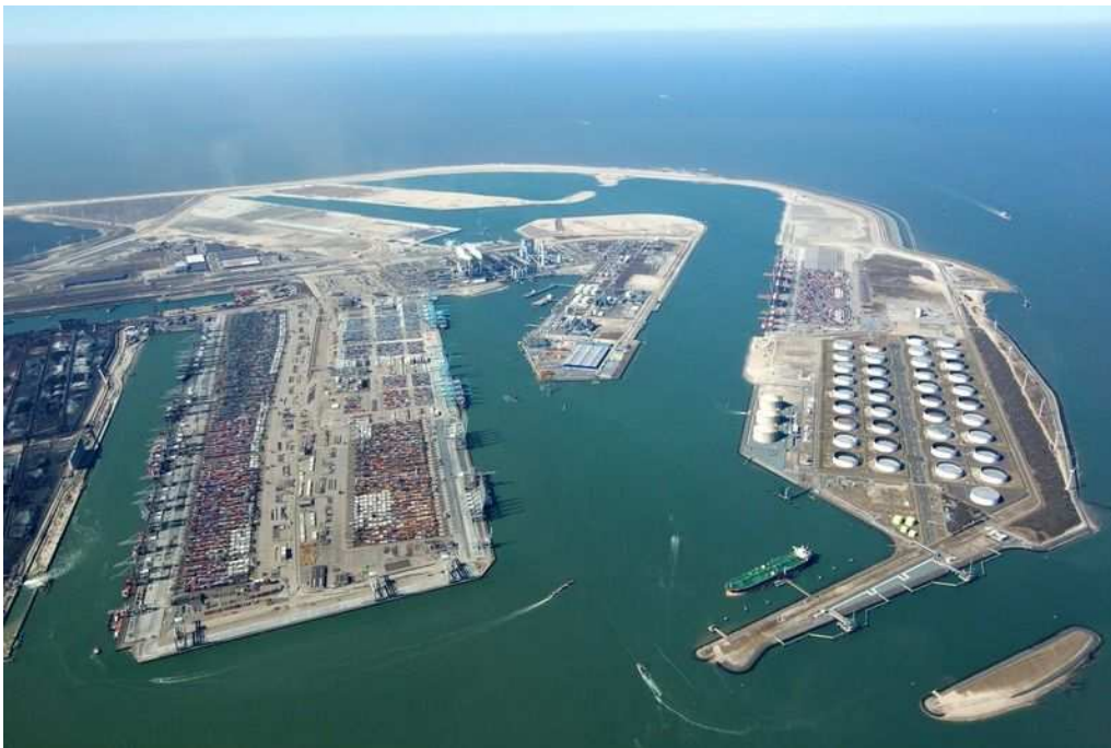
Figure 6.4. Maasvlakte 2 : une extension portuaire sur la mer
