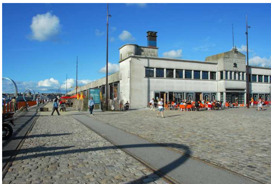
Figure 7.8. Nantes : le hangar à bananes
