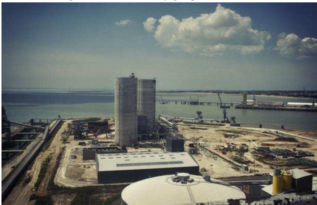
Figure 5.4. Le centre de broyage Eqiom à La Rochelle
