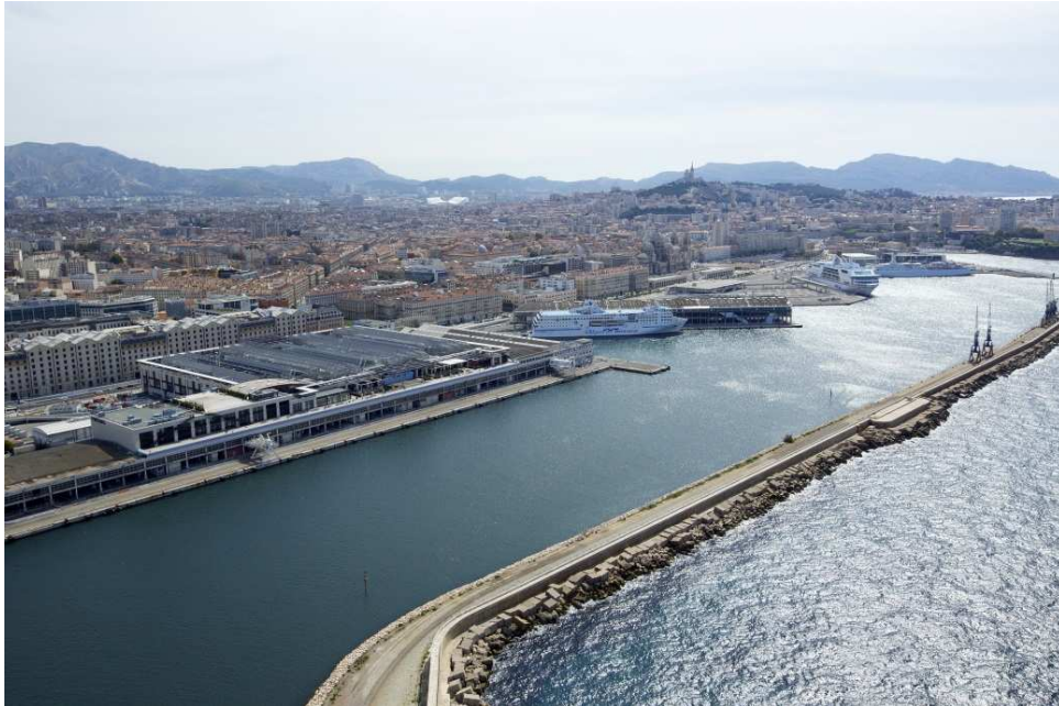
Figure 7.10. Marseille : un centre commercial sur le port
