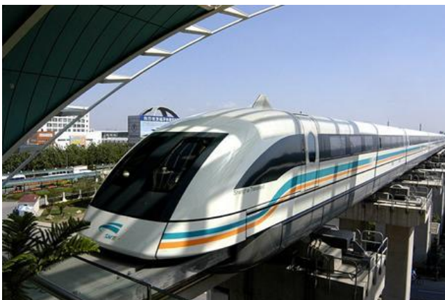
Fig.17 : Photo du Shanghai Transrapid basé sur la lévitation magnétique.
