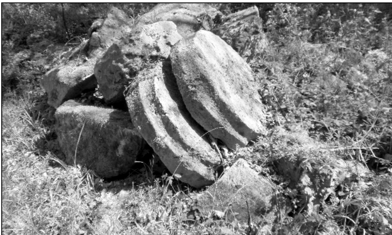
Doc. 289 et 290. La halle de Marciac peu avant 1880, photo découverte par Maurice Serres. Détail de vestiges des piliers de cette halle déposés dans le parc du château de Guitou à Marciac. Photographie S. A., 2013.
