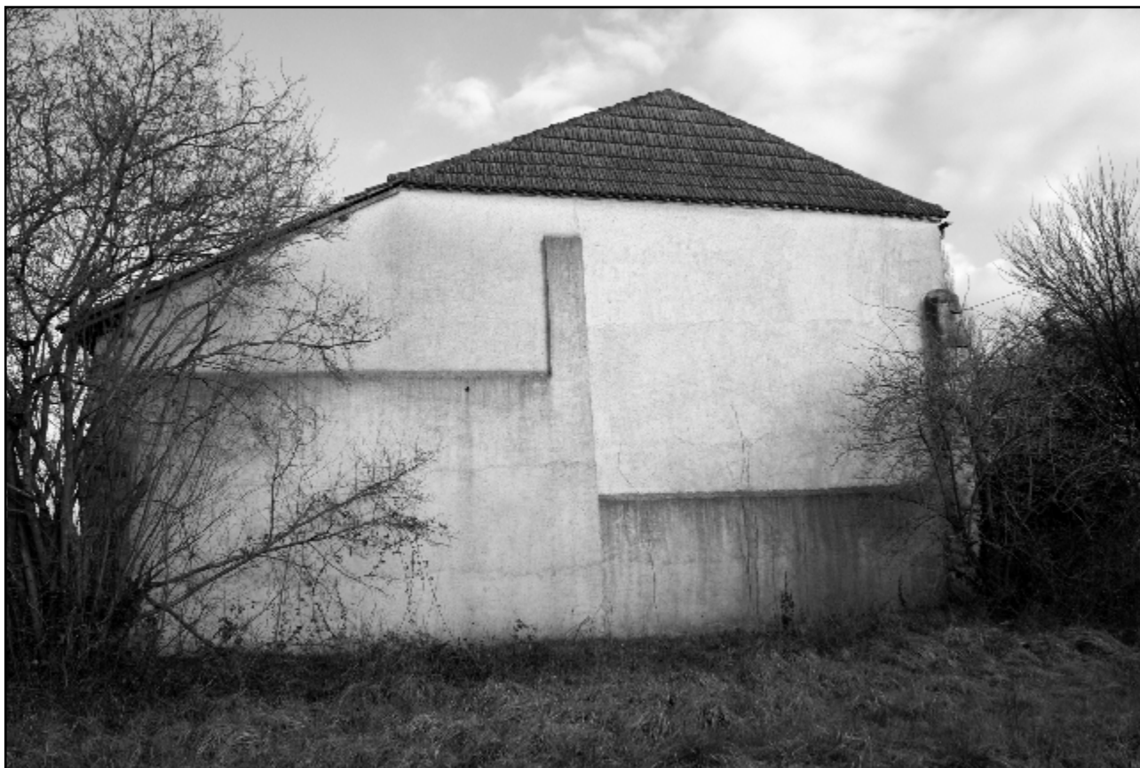
Doc. 40. La façade ouest du bâtiment B, qui montre plusieurs irrégularités provenant d'un autre bâtiment qui lui était accolé (probablement la « nouvelle » abbatiale). Photographie S. A., 2013.
