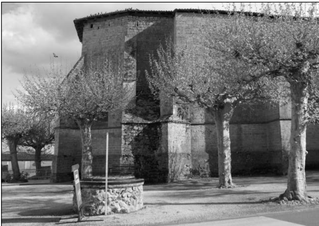
Doc. 291 et 292. Le puits de la place centrale de Beaumarchès, devant la mairie (en haut) et le puits de la place de l'église. On distingue encore la margelle originelle chanfreinée, sous la réfection contemporaine. Photos S. A., 2013.
