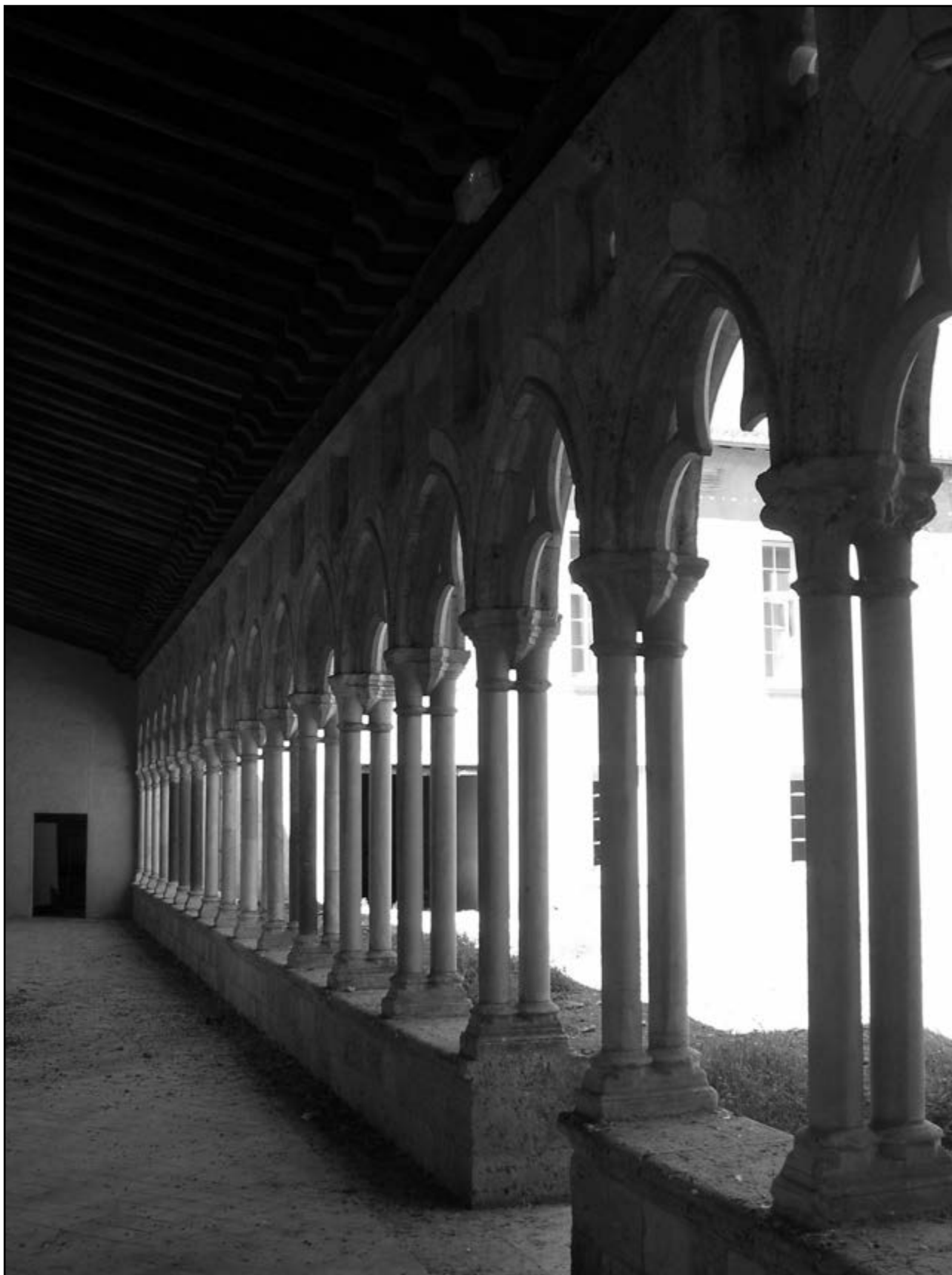
Doc. 114. La galerie remontée du cloître des Cordeliers d'Auch (XIV e s.). Photo S. A., 2008.
