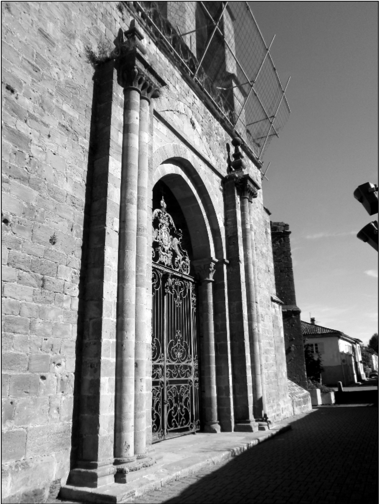
Doc. 55. Vue générale du portail du clocher de Notre-Dame-de-l'Assomption de Marciac, remployé entre deux massifs de pierres de taille provenant de l'ancienne abbatale de la Casedieu. Les piliers sont surmontés de balustres provenant sans doute de la même abbaye. Photographie S. A., 2013.
