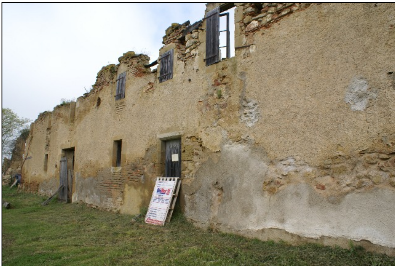
Doc. 179. La grange de Marrens à Montesquiou, état actuel vu du sud-est. Photographie S. A., 2013.
