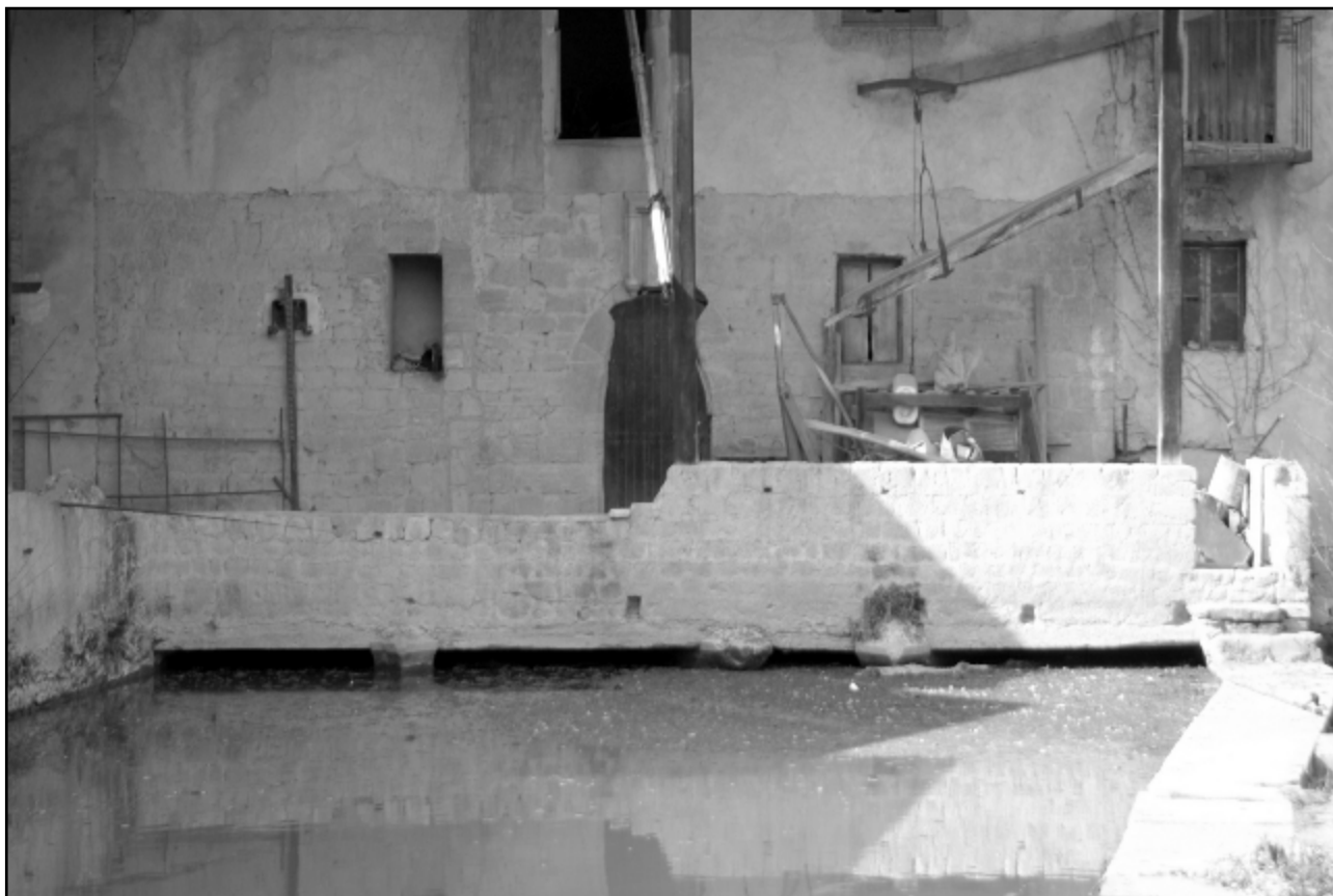
Doc. 255. Façade sud du moulin de la Casedieu à Plaisance (1462). Photo S. A., 2014.
