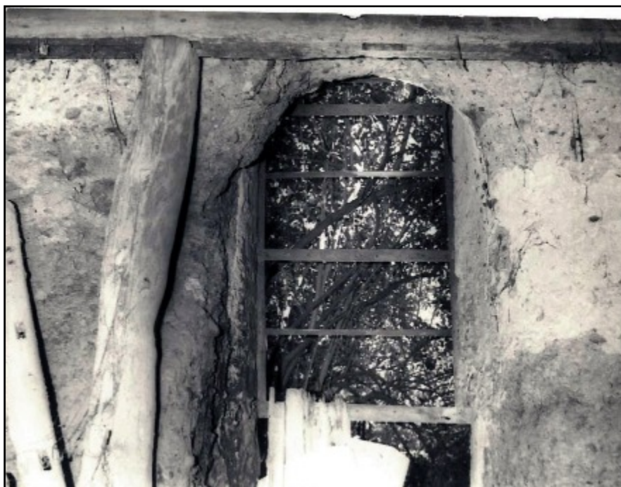
Doc. 299 et 300. Vestiges de la muraille en pisé et galets de la bastide de Plaisance, observés en 1976 avant sa destruction pour construire le parking au sud-est de l'actuelle mairie. Photographies du fonds Alain Lagors.
