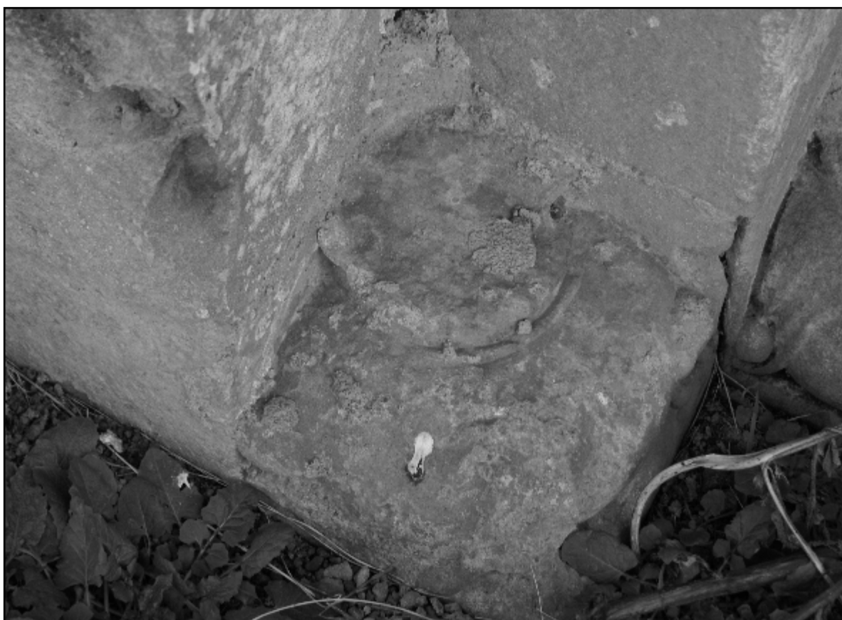
Doc. 33. Détail du portail précédent : base à griffes d'angle en forme de feuilles (fin XII e -XIII e siècle ?). La colonne sus-jacente, disparue, était collée par du mortier à cette base. Photographie S. A., 2012.
