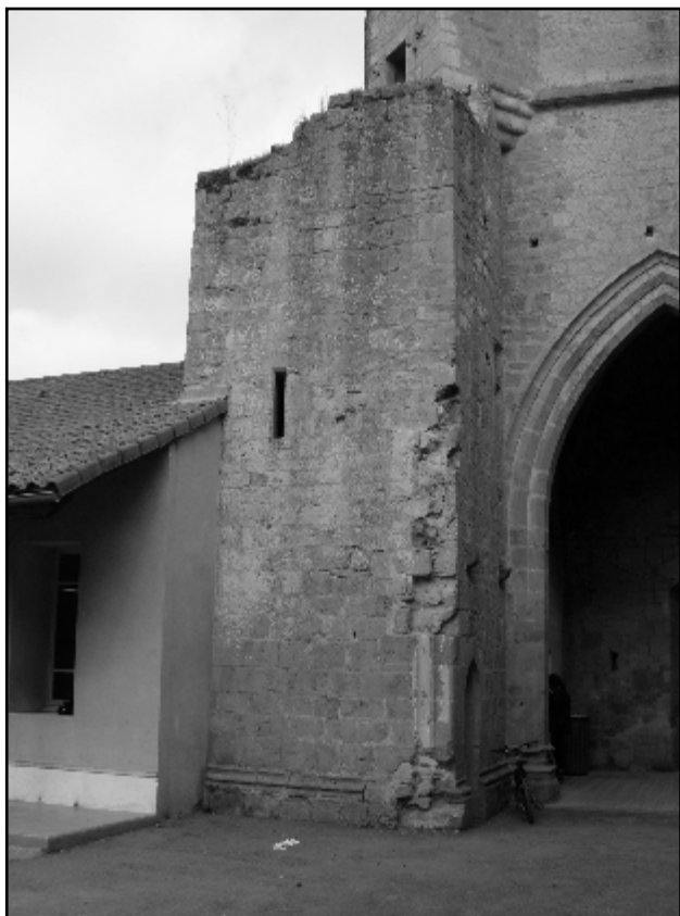
Doc. 323 et 324. État actuel des arrachements du cloître sur la tour d'escalier du clocher et le mur nord de l'église abbatiale des Augustins de Marcillac. Photographies S. A., 2014.
