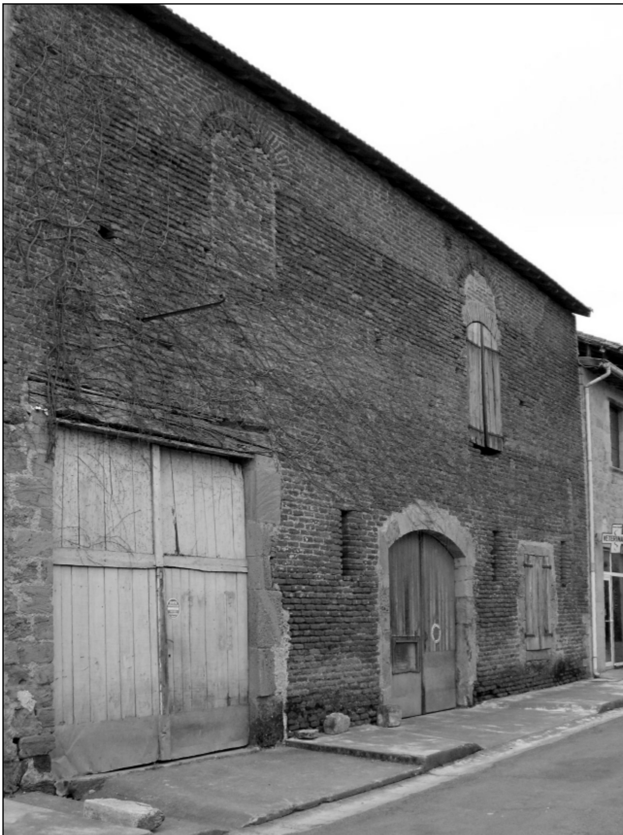
Doc. 313. Maison en briques de style gothique 24, rue des Lilas à Marciac. (Parcelle n°172 du cadastre, section C5 Noter les deux vues à ébrasement du rez-de-chaussée et les deux fenêtres géminées occultées de l'étage. Photo S. A., 2013.
