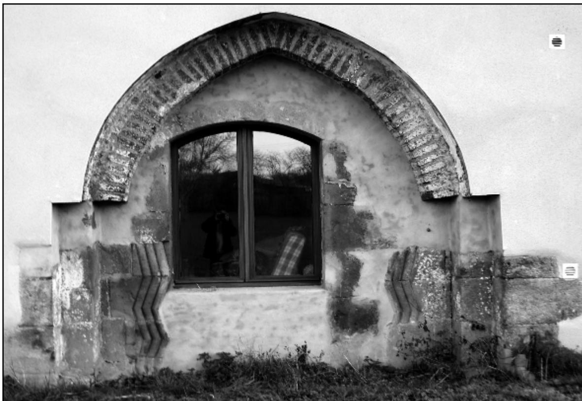
Doc. 32. Le portail nord du bâtiment A. Ce portail conserve des bases et deux piédroits (XII e -XIII e s. ?) et une voûture en briques très postérieure (XVII e s. ?). Photographie S. A., 2012.
