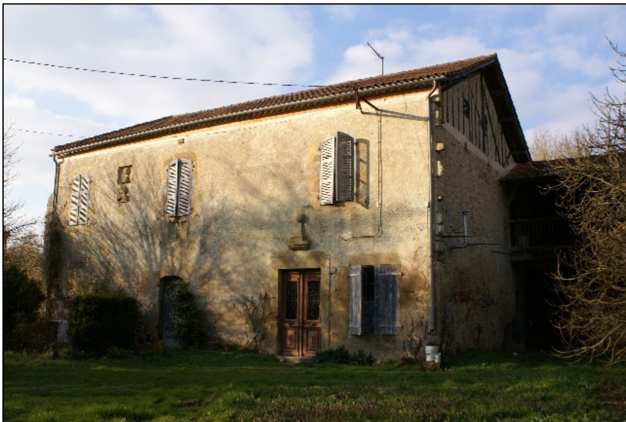
Doc. 38. La Casédie, façade sud du bâtiment B, avec ses remplois. Photographie S. A., 2013.
