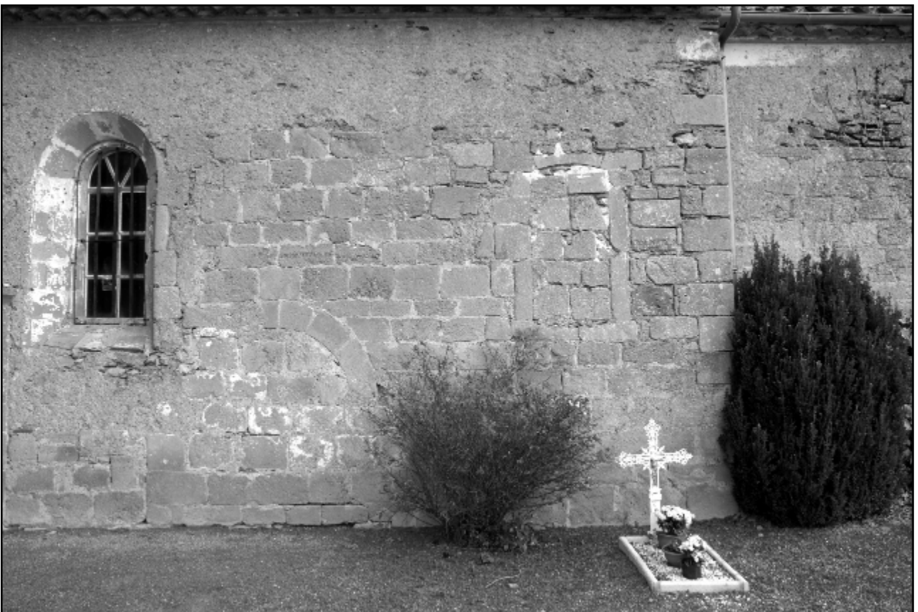
Doc. 221 et 222. L'église d'origine romane de Ricau à Beaumarchès. Vue du mur nord et du mur sud. Photo S. A., 2012.
