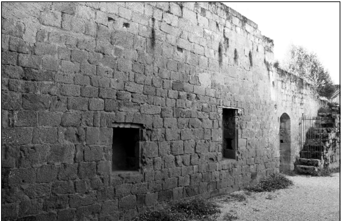
Doc. 331 et 332. Façade de la maison des abbés et vue intérieure ouest, avec placards muraux et escalier. Photographies S. A., 2013.
