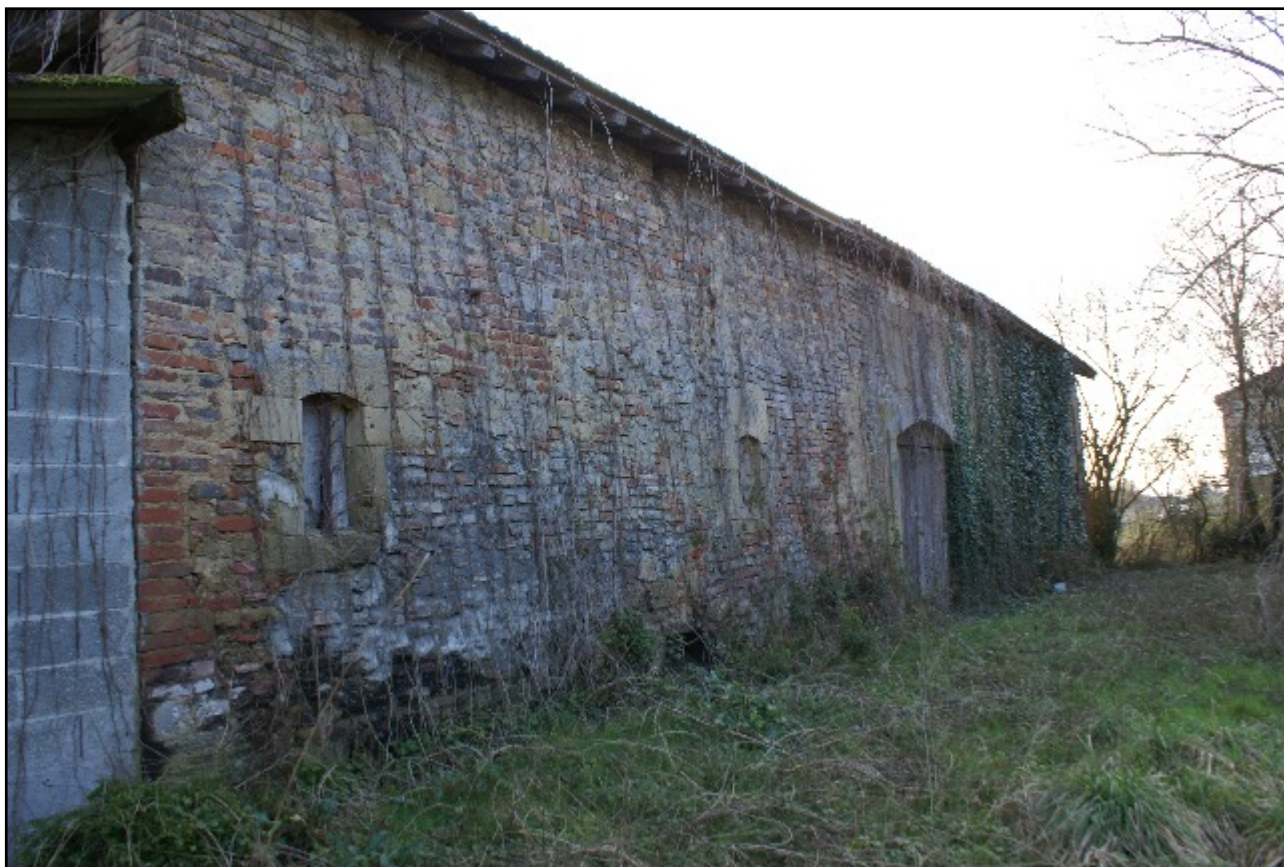
Doc. 39. La façade nord du bâtiment B, formée de briques de remploi. Photographie S. A., 2013.
