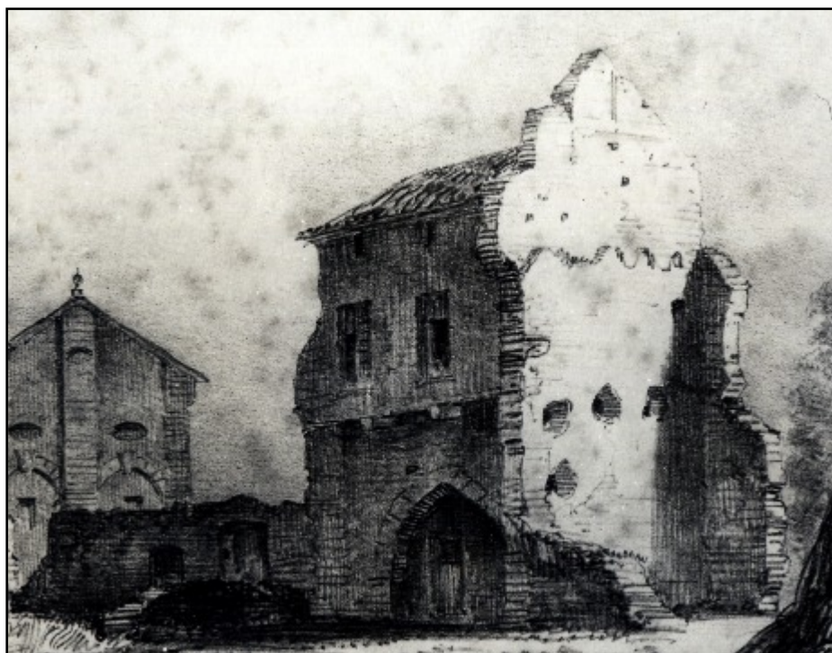
Doc. 31. Le bâtiment A sur la gravure de la Guienne monumentale d'Alexandre Ducourneau en 1844. On distingue très bien sur ce détail de la gravure que l'actuel bâtiment A n'est en fait que le vestige d'un ensemble de pièces déjà presque entièrement arasées à l'est et à l'ouest en 1844.
