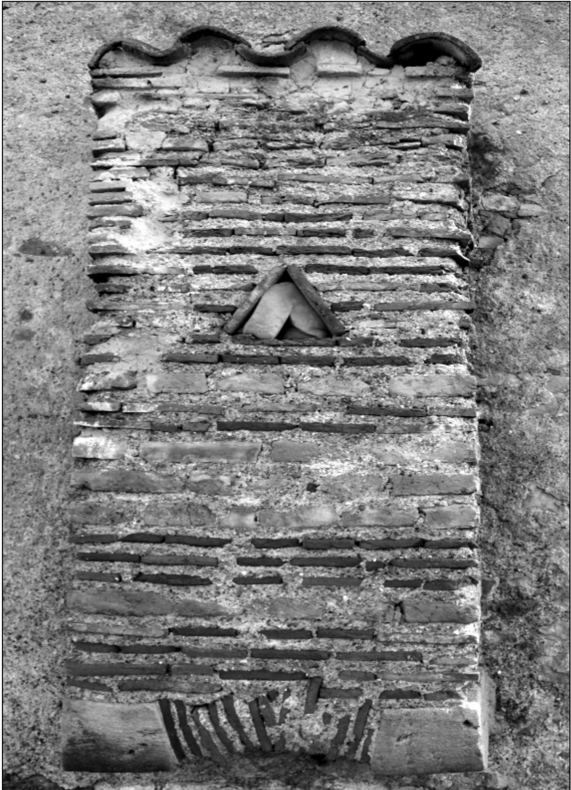
Latrine en encorbellement au sud du bâti de la grange de Marrens, à l'emplacement d'anciens fossés. Photographie S. A.
