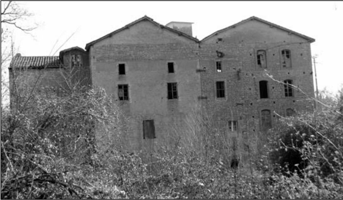
Vue générale de la façade nord du moulin de Plaisance. Photographie S. A., 2013.
