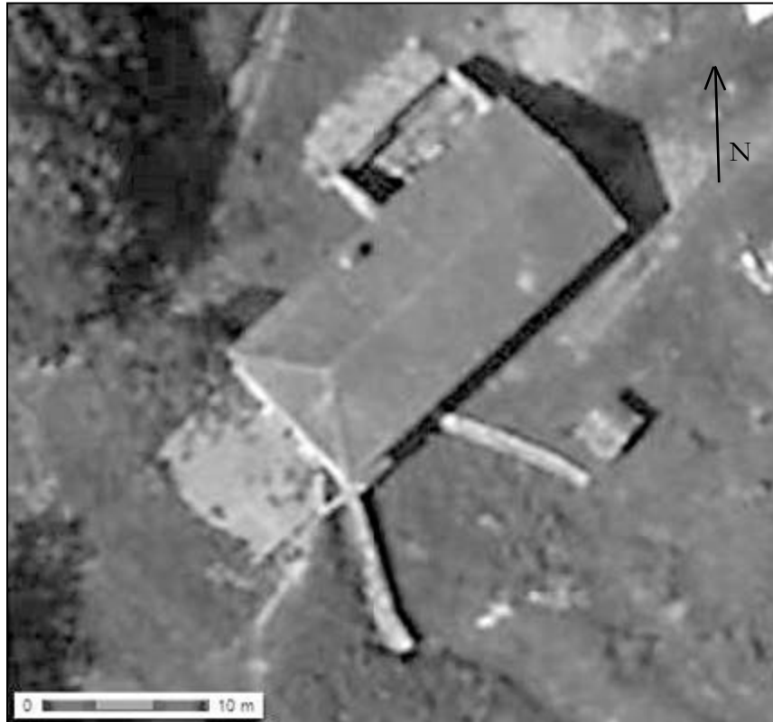
Photographie aérienne verticale du moulin du Baylé Fonds IGN/Géoportail.
