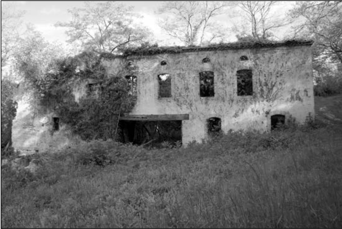
Le moulin de Caumont, état actuel vu du sud. Photographie S. A., 2013.
