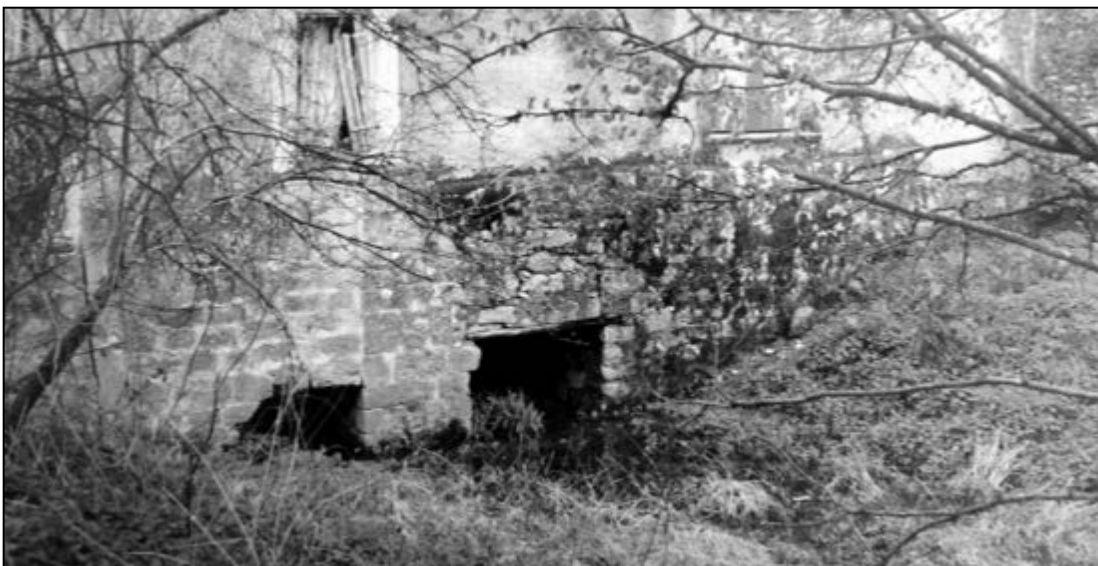
Les fondations du moulin de Pallanne (face nord) en 2007. Photographie M. Davies, 2007.
