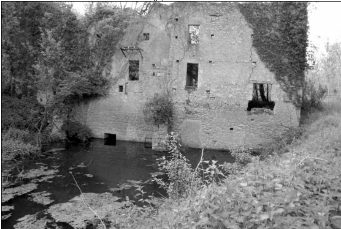
Le moulin de Caumont, état actuel vu du nord. Photographie S. A., 2013.
