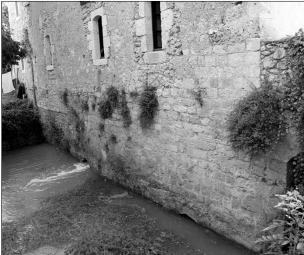
Le moulin de Laumet, état actuel, façade Est. Photographie S. A., 2014.
