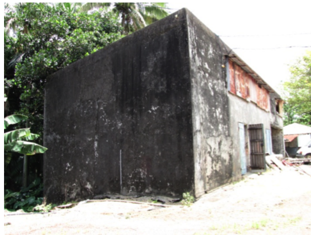
FIGURE 1.10 – Photographie du bâtiment actuel de l'espace artisanal
