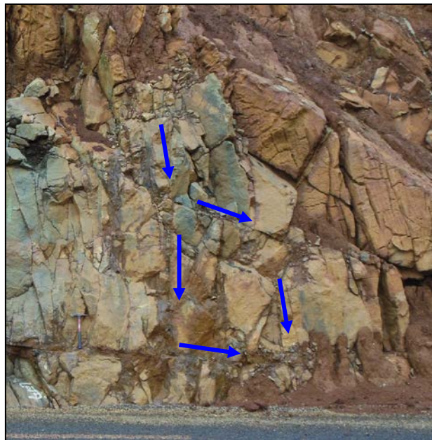
Figure 87 : Suintements au sein du réseau de fractures serpentinesse et directions d'écoulement observées (flèches bleues), col Paillard, Massif du Sud.
