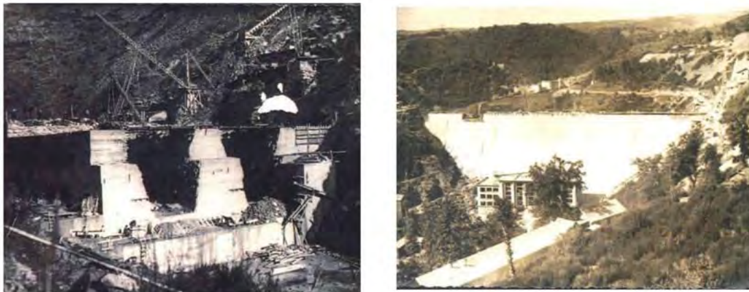
Figure 4-25 : Photographies du coulage des plots du barrage
