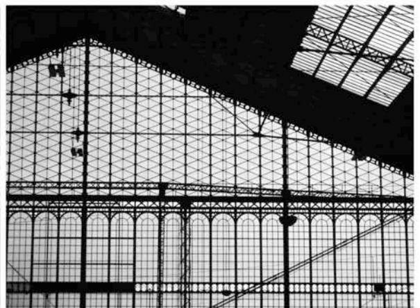
Verrière de la gare d'Austerlitz (Paris)
