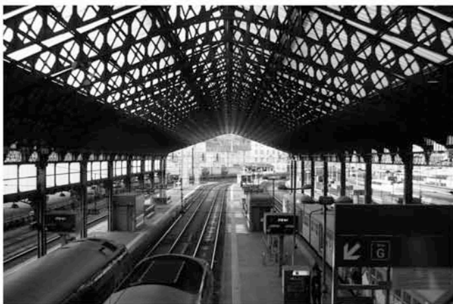
Halle Polonceau (Gare de Lyon-Perrache)
