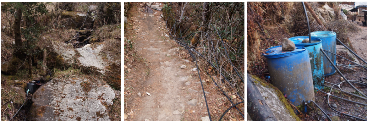
(a) Prises d'eau dans la rivière (b) Tuyaux d'adduction le long du chemin de trek (c) Citernes d'adduction collective
