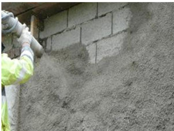
Figure I. 30 : Béton de chanvre projeté sur mur<sup>6</sup>
