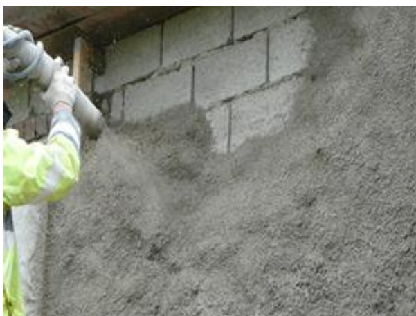
Figure I. 30 : Béton de chanvre projeté sur mur 6
