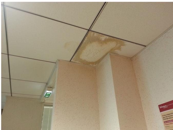
FIG. 4.8: écoulement d'un toit dans un établissement public.
