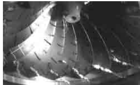
(d) Vortex cavitants dans les canaux interaubes d'une turbine Francis à charge partielle. Source : Bouajila et al. [10].
