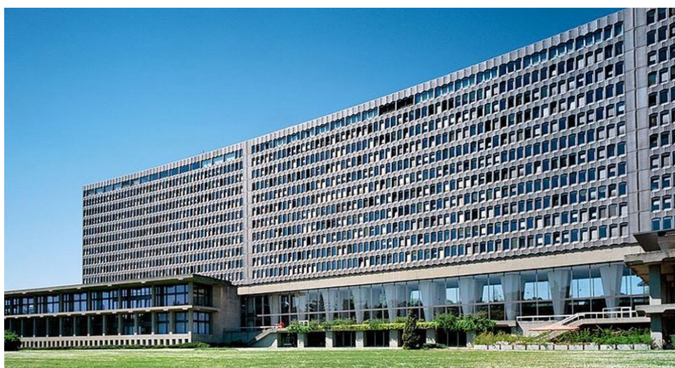
Figure 30 : le bâtiment central de l'OIT (Genève, 2012)
