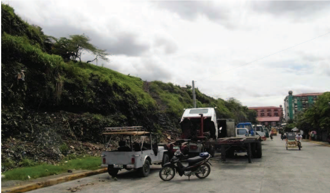
PHOTO 2. Gravier Paradise Gate : l'accès sud à Smokey Mountain
