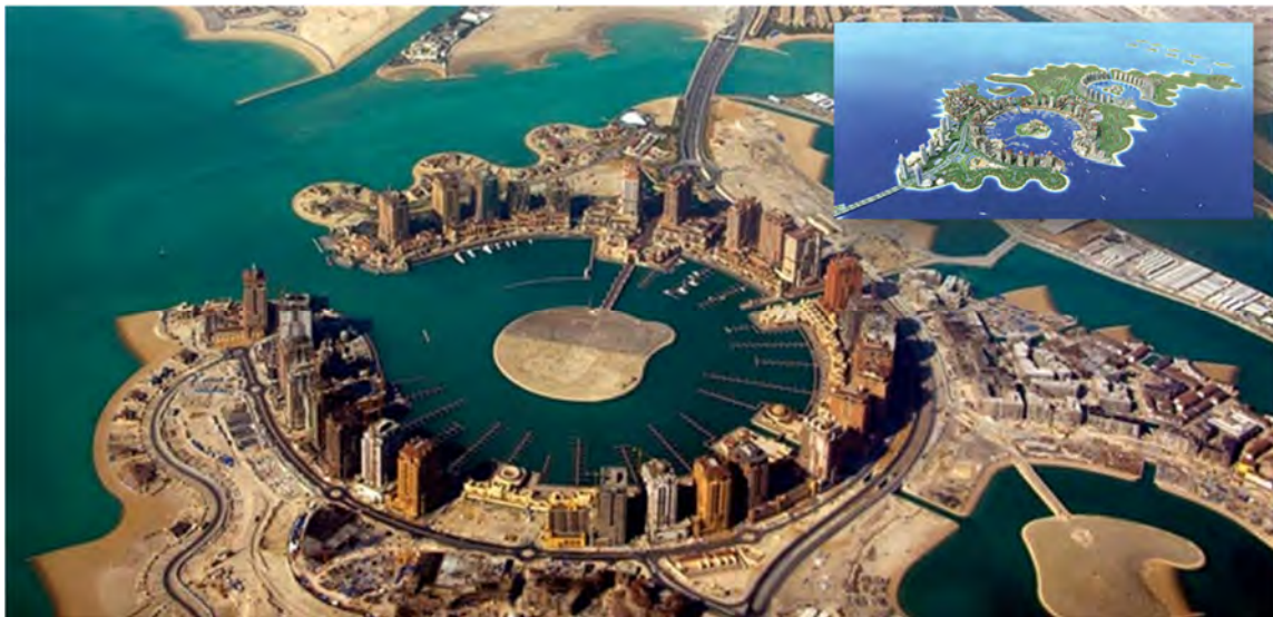
Figure 8.25. Pearl-Qatar - l'île artificielle formée par l'empiètement sur la mer
