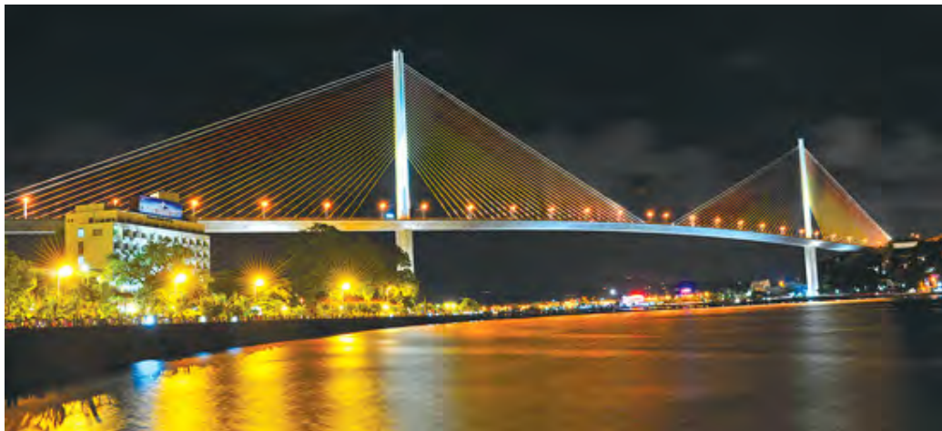
Figure 3.2. Pont à haubans de Bai Chay et le bac de Bai Chay - Hon Gai sur la baie d'Ha Long et Cua Luc
