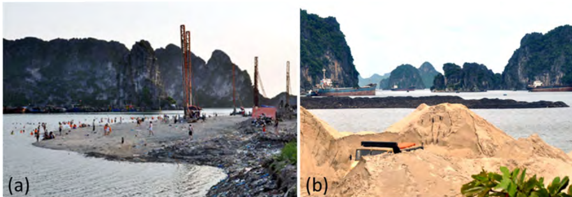
Figure 8.26. Empiètement du territoire urbain sur mer sans batardeau à Cot 3 (a) et Coc 6 (b), Cam Pha, Quang Ninh
