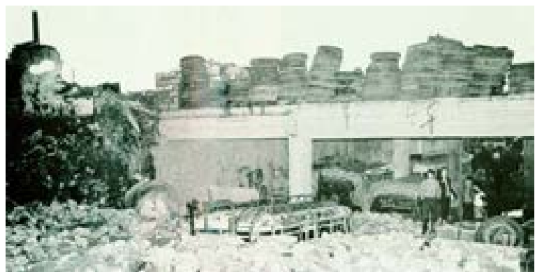
Le garage de Bab et-Tabbaneh recouvert de gravats charriés par la crue du 17 décembre 1955. Source : collection de l'auteur.
