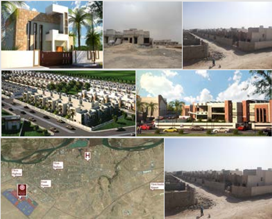
Figures n° VII.8. – Vues du projet Tikrit Jewel (Irak) dont les montages financiers et juridiques ont été réalisés par SACS Inc.
