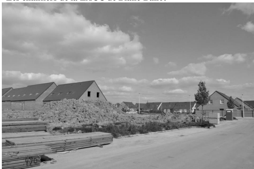
Figure n°45. Les chantiers de la ZACC de Blanc-Ballot
