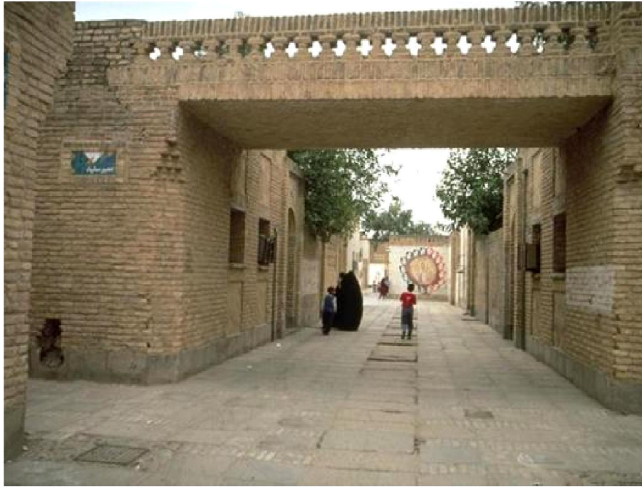
Photo 33- Une ruelle à Shushtar No, utilisation des matériaux et des éléments traditionnels Source : www.archnet.org
