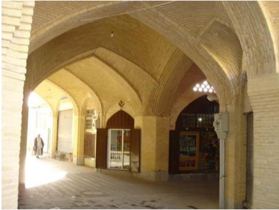
Photo 37- Sauvegarde de l'identité historique par la restauration et la revitalisation des fonctionnes traditionnelles, quartier Jamaleh à Ispahan source : www.ufi-ngo.ir
