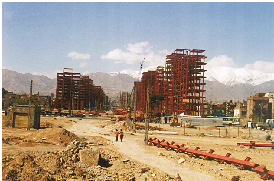
Photo 52- La construction de la 1 ère phase du projet Navvab (1995) Source : Archive de l'ORUT
