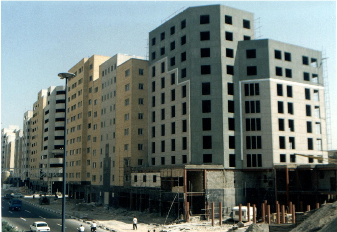
Photo 59- Construction de la phase 3(a) du projet Navvab (2001), conçue par Atec. Source : Archive de l'ORUT
