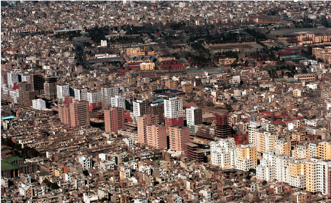
Photo 62- Blocs de Navvab, comme un immense mur interrompent la cohésion spatiale du tissu existant (2001) Source : Archive de l'ORUT
