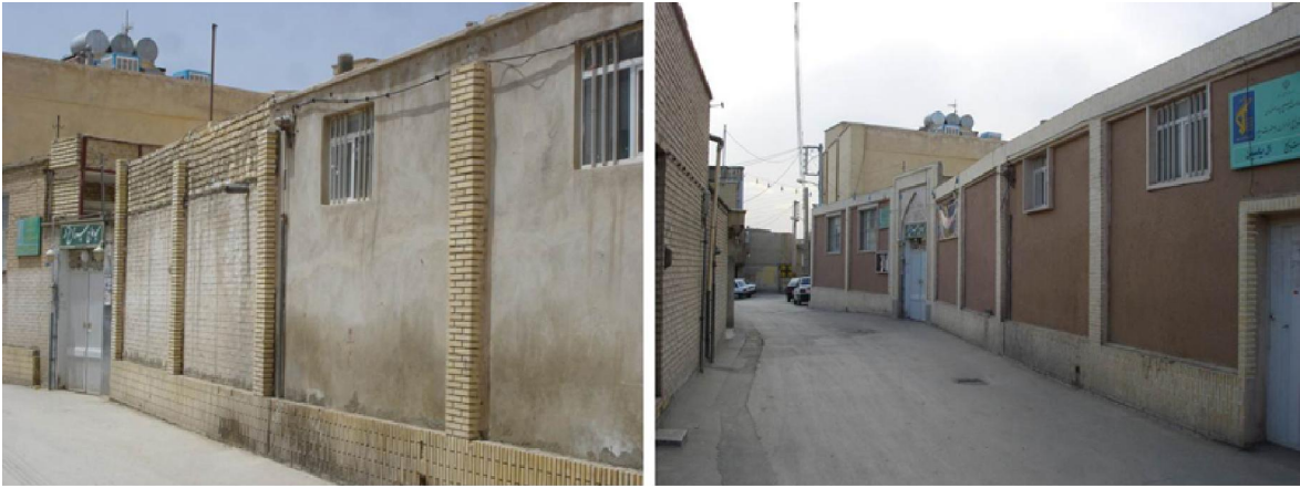
Photo 35- Embellissement des façades sur le modèle traditionnel était l'axe principal de rénovation du quartier Jamaleh à Ispahan, les façades avant et après la rénovation (1990)
