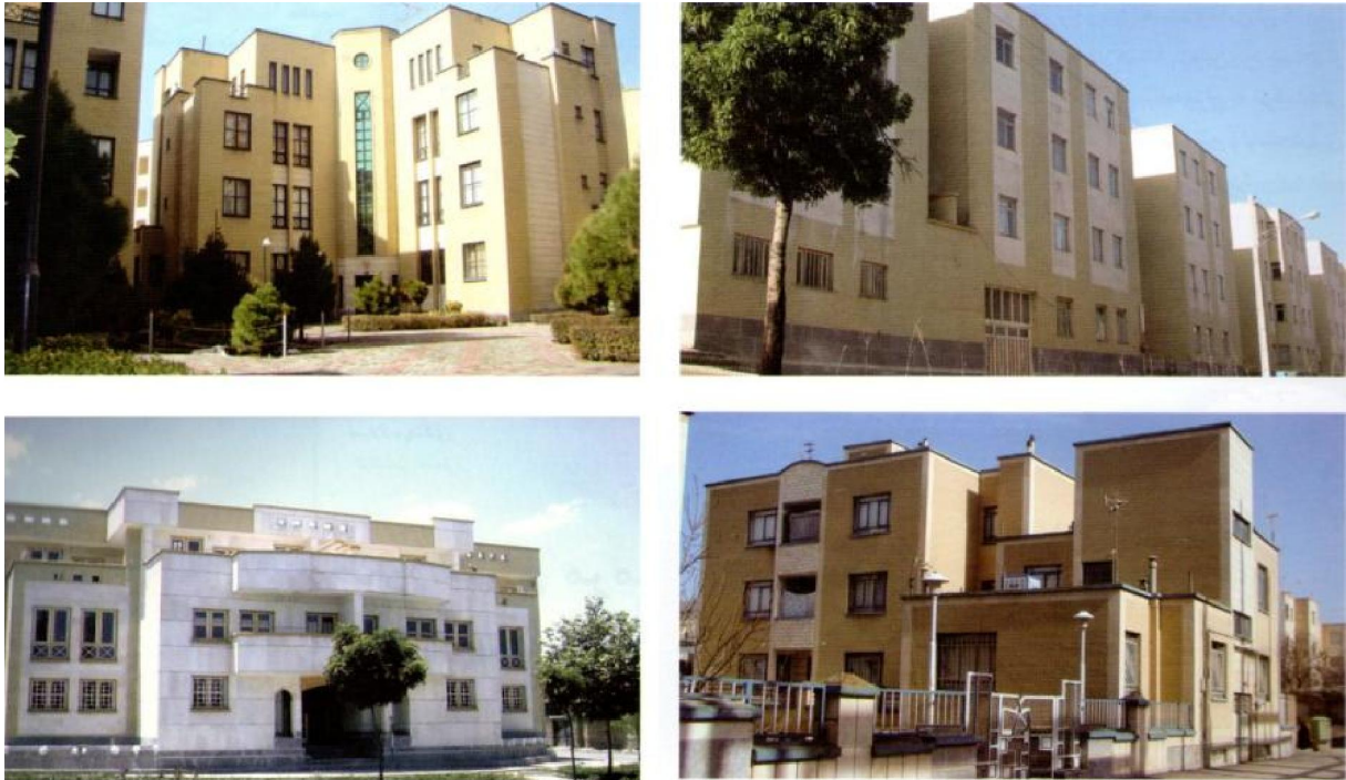
Photo 40- Les habitations collectives du quartier Jolan, traiter l'identité urbaine avec l'architecture postmoderne et l'utilisation des matériaux déterminés pour les façades (brique et pierre blanche) source : Asadi, 2009 :114
