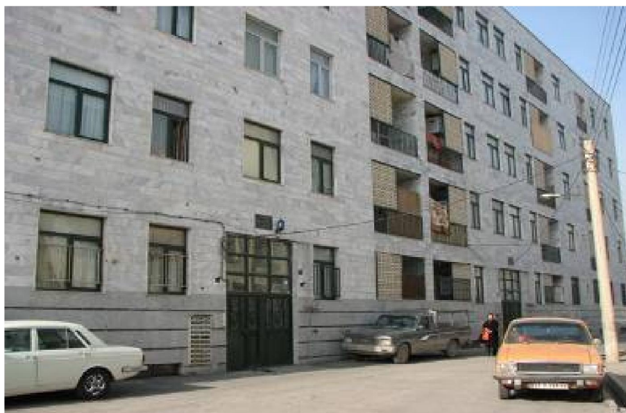
Photo 49- Des nouvelles constructions sur les maisons initiales et le nouveau visage de la cité de 13Aban source : Maddah, 2009 :86
