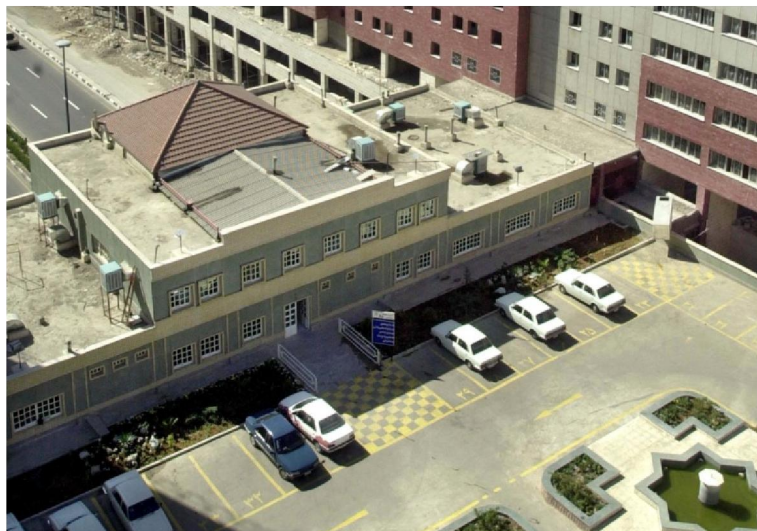
Photo 65- Ayant été transformé en bureau de la mairie, l'édifice du point-bazar n'a jamais servi aux habitants Source : Archive de l'ORUT
