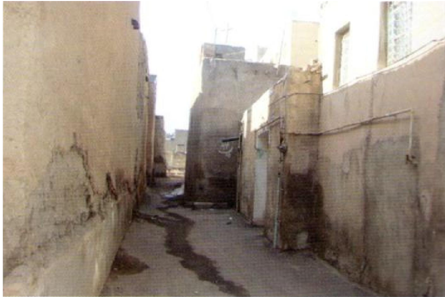
Photo 38- Situation des allées avant la rénovation (1996), quartier Jolan à Hamadan Source : Asadi, 2009 :114
