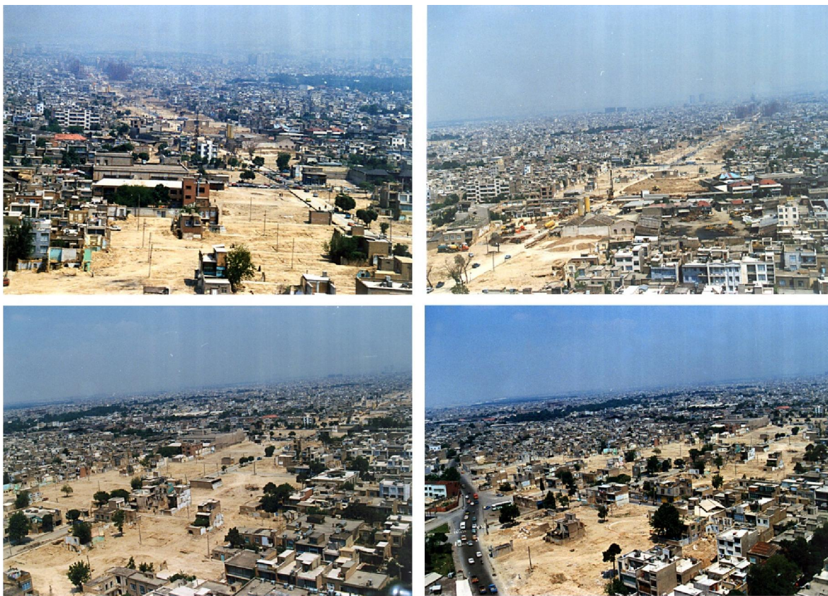
Photo 51- Des vues de la démolition et du rasage des sites dans le projet Navvab Source : Archive de l'ORUT
