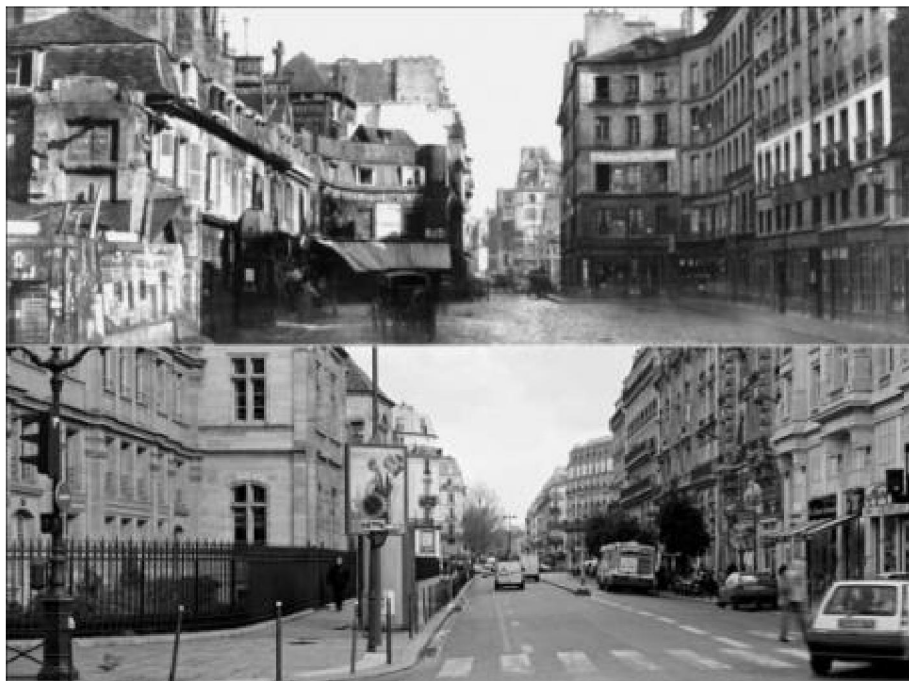
Photo 2- L'élargissement de la rue Réaumur ; avant et après les rénovations Hausmanniennes Source : www.lefigaro.fr
