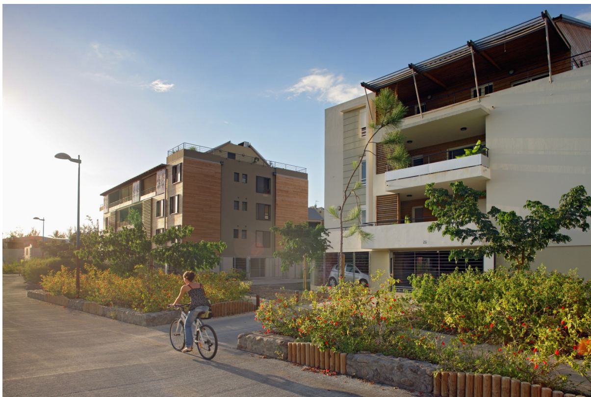
Figure 80 Traitement des limites entre l'espace public et l'espace privée (crédit photo Rémy Ravon)
