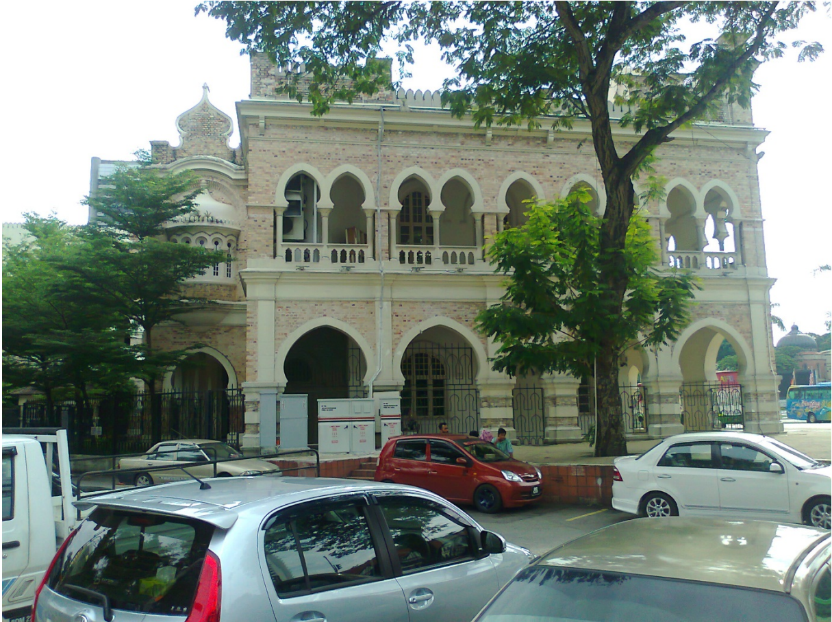
Figure 54 Exemple d'architecture pastiche à Kuala Lumpur : les qualités vernaculaires ont en partie été retranchées – présence de climatiseurs en haut à gauche- (crédit photo auteur)
