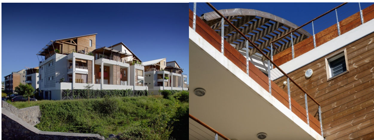
Figure 78 L’utilisation du bois sur les opérations « La Vierge du Cap » et « Hermione » dans le quartier de la Cocoteraie (Crédit photo Rémy Ravon)
