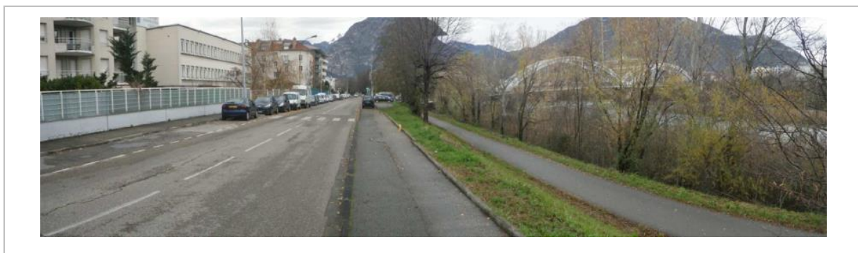
Figure 7-6. Tronçon 2, Profil : P119 - Vue vers l'aval : voirie lourde en crête et talus côté plaine remblayé (après la rue de Chamrousse)
