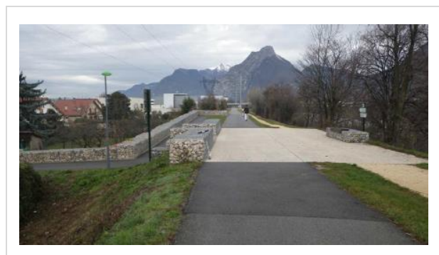
Figure 7-5. Tronçon 1, Profil : P107 - Vue vers l'aval : voie d'accès de la rue Sisteron et aire de repos
