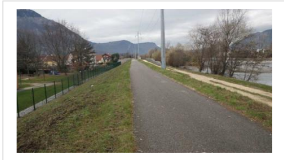
Figure 7-12. Tronçon 3, Profil : P138 - Vue vers l'aval
