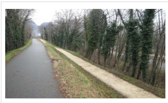
Figure 7-2. Tronçon 1, Profil P91 - Vue vers l'aval
