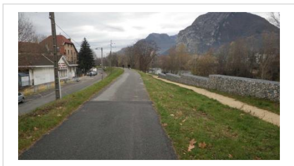
Figure 7-10. Tronçon 3, Profil : P128 - Vue vers l'aval
