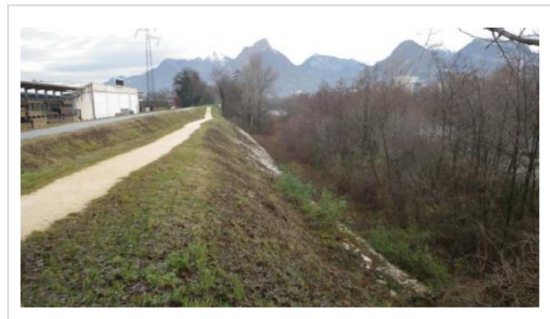
Figure 7-3. Tronçon 1, Profil P93 - Vue vers l'aval
