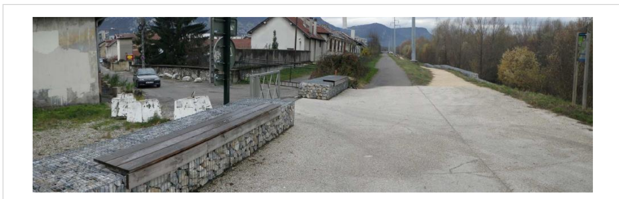
Figure 7-9. Tronçon 3, Profil : P133 - Vue vers l'aval : voie d'accès et côté plaine remblayé (rue Jean Pain)
