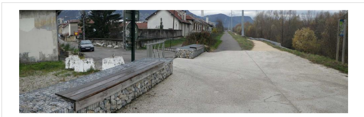
Figure 7-9. Tronçon 3, Profil : P133 - Vue vers l'aval : voie d'accès et côté plaine remblayé (rue Jean Pain)
