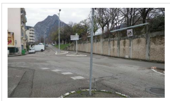
Figure 7-7. Tronçon 2, Profil : P123 - Vue vers l'aval : mur béton rue de la Liberté
