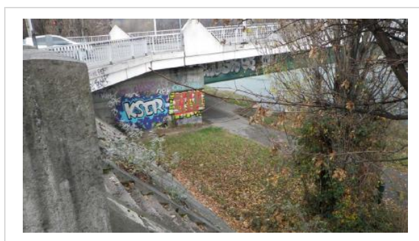
Figure 7-8. Tronçon 2, Profil : P124 - Vue vers l'aval : talus côté rivière mur béton
