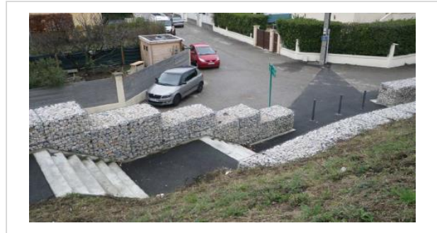
Figure 7-13. Tronçon 3, Profil : P39/P140 - Vue vers l'aval : voie d'accès rue des Rachais
