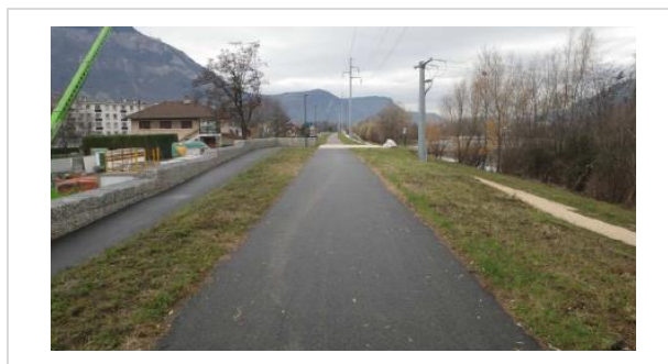
Figure 7-11. Tronçon 3, Profil : P136/P137 - Vue vers l'aval : voie d'accès rue Aubert
