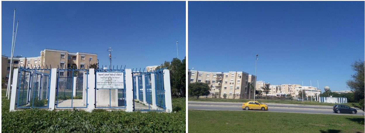
Figure 62 : Station de surveillance de la qualité de l'air de Radès. (Photos : Ben Romdhane S., 2017).
