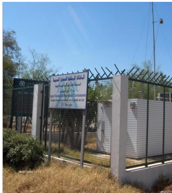
Figure 67 : La station de proximité industrielle de Ben Arous. (Source : ANPE).
