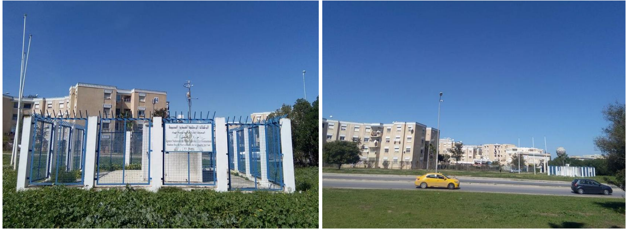
Figure 62 : Station de surveillance de la qualité de l'air de Radès. (Photos : Ben Romdhane S., 2017).
