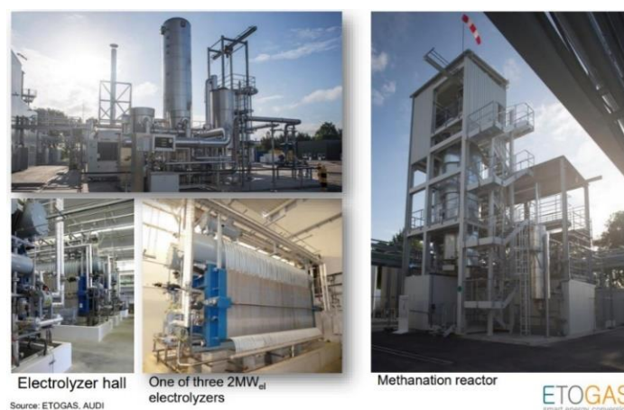
Figure I.18 : Unité commerciale E-Gas Audi à Werlte. 41
