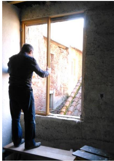
Figure 10 : Mise en place d'une menuiserie avec un châssis en bois de châtaigner
