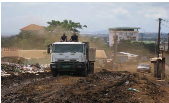
Entrée de la décharge complètement dégradée
