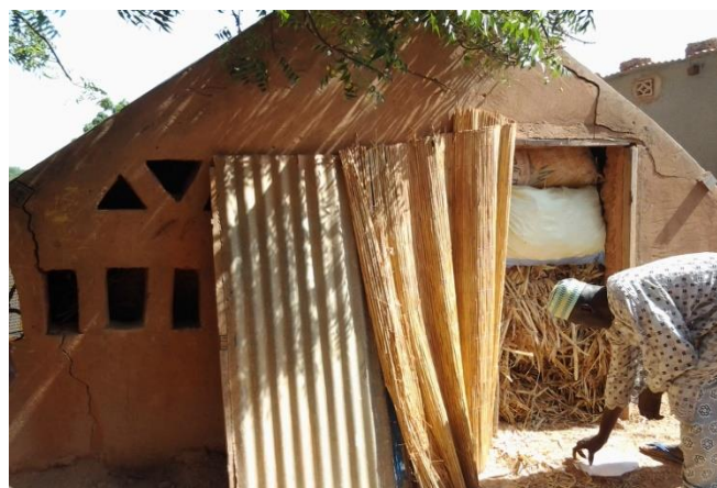
Photo 32 : stockage d'aliment bétail dans un fénil, mars 2014
