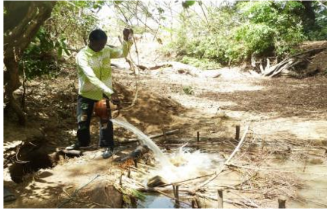
Photo 28: Exhaure d'eau à partir du puisard creusé dans le bas-fonds de la Nouhao , mars 2014
