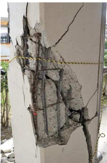
Pilier en béton désintégré designarchitecturart.com
