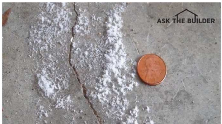
Fracturation et efflorescence associées sur un béton ask the builder.com
