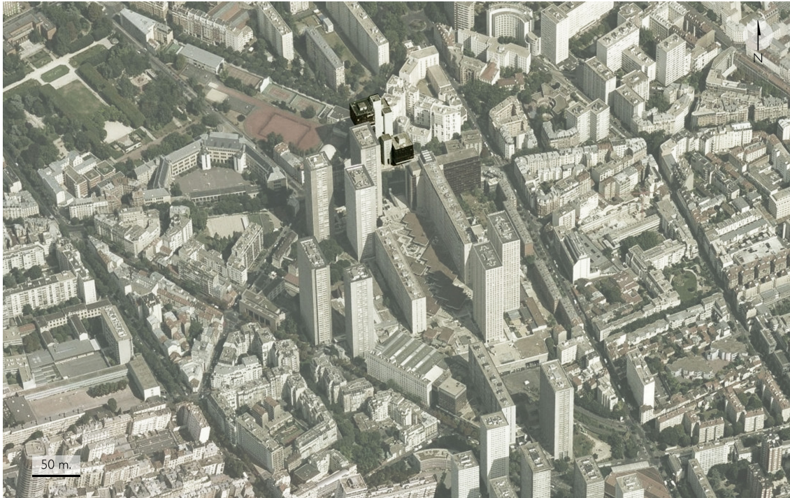
Figure 4.4 : Vue aérienne du centre Pierre Mendès France (Tolbiac) de Paris I
