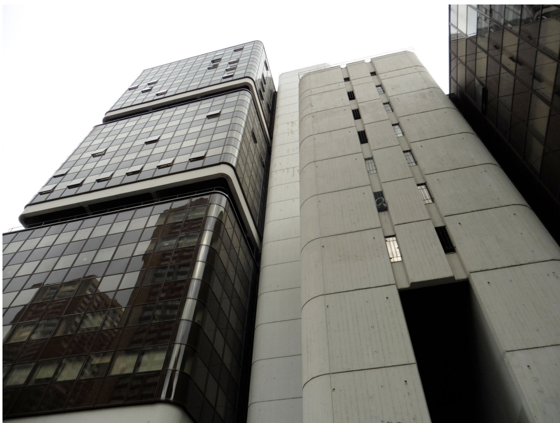
Figure 4.2 : Photographie du centre PMF Tolbiac
