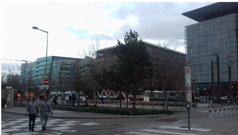
Cliché 6. Vaux la Soie un quartier entièrement réaménagé
