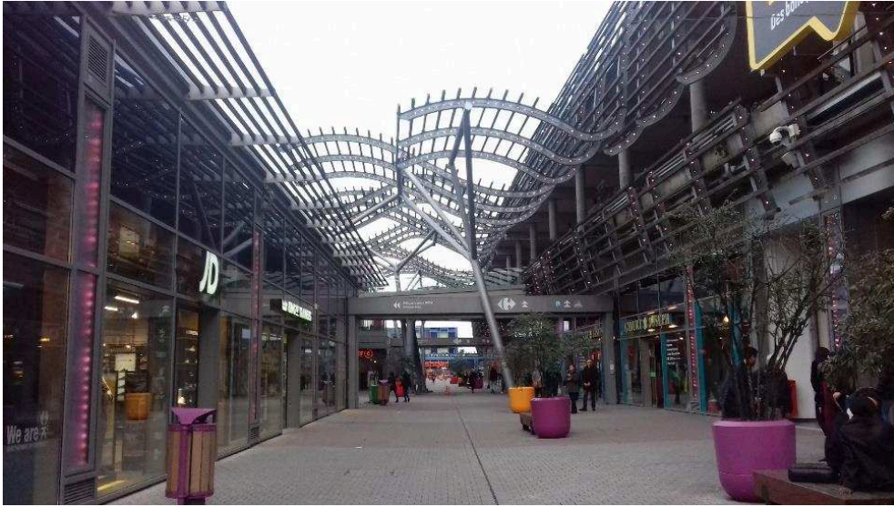
Cliché 7. Le Carré de Soie, un centre commercial à ciel ouvert
