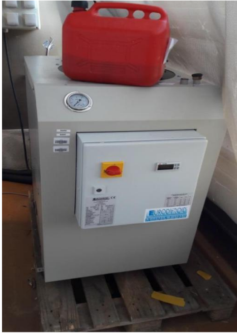
Figure III-16 : refroidisseur d'eau glycolée , Echangeur Air/eau
