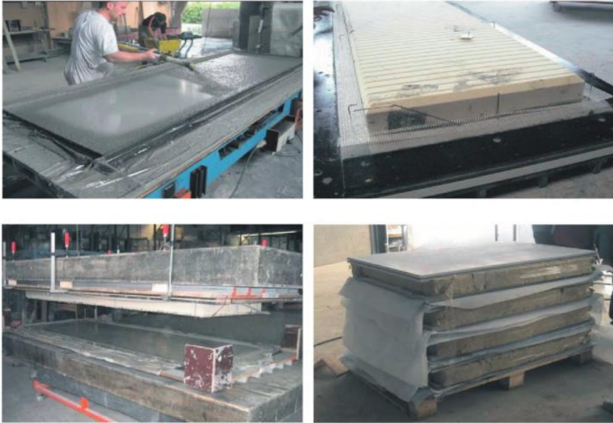
Figure II-23 : Fabrication de panneaux de façades par la technique de stratification (Brameshuber et al., 2016)
