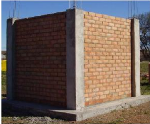
Cabine en briques perforées
