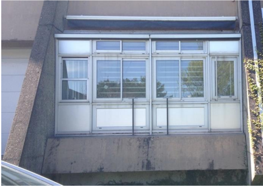
Figure III-51 : Etat initial de la façade extérieure de la cellule HYBCELL
