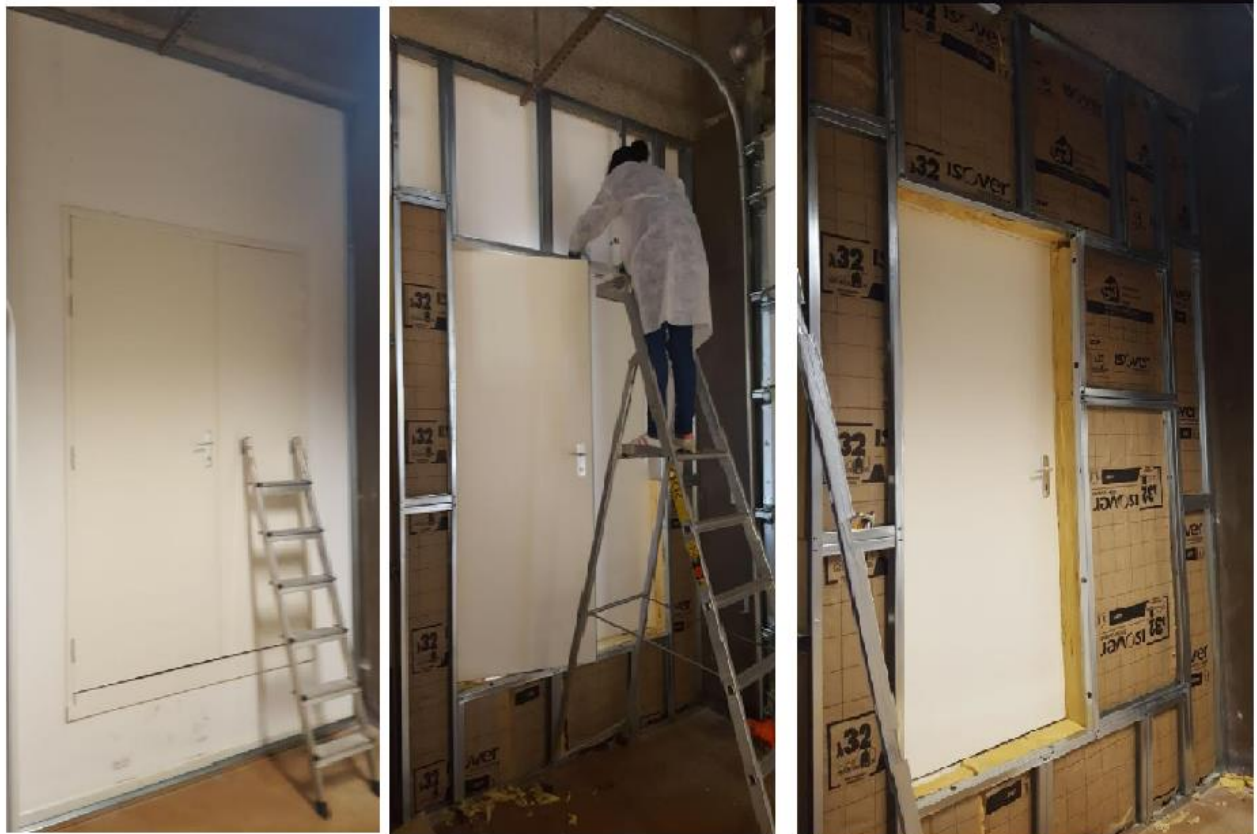
Figure III-55 : Isolation du mur sud adjacent au laboratoire B3
