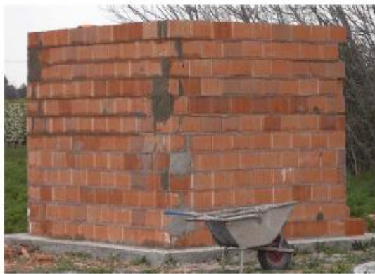
Cabine en briques alvéolaires
