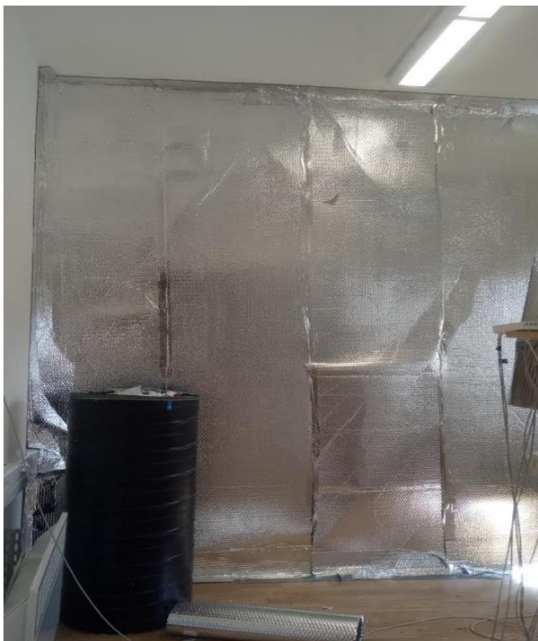
Figure III-67 : Isolation du mur de séparation entre les deux cellules A et B
