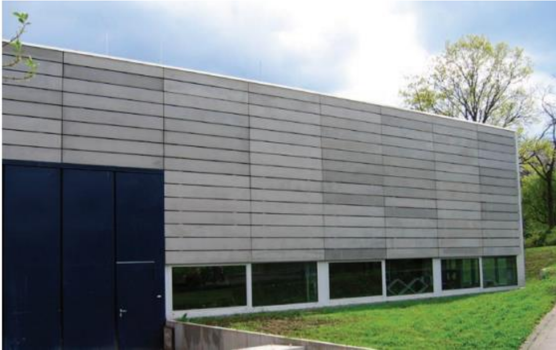
Figure II-30 : Eléments de façades ventilées (Hegger et al.,2008)
