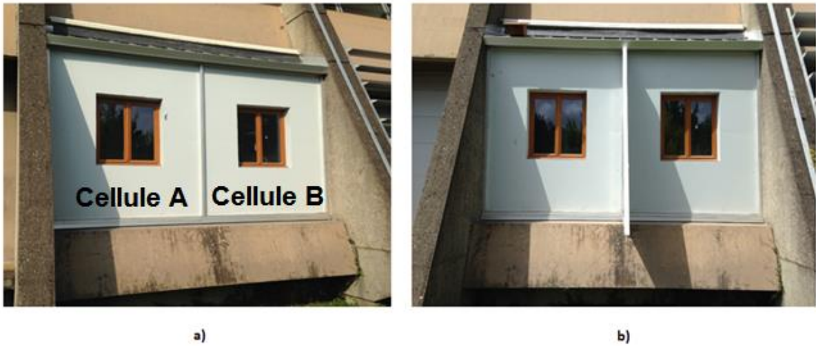
Figure III-61 : Rayonnement solaire sur la façade extérieure de la cellule HYBCELL a) avant installation du trapèze ; b) après installation du trapèze
