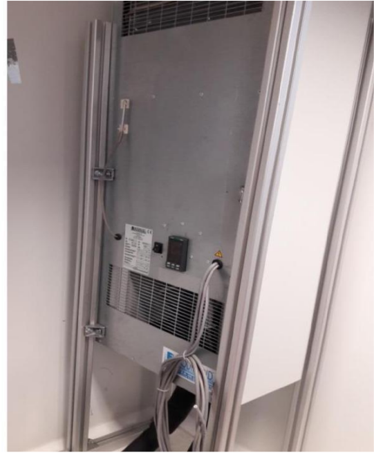
Figure III-16 : refroidisseur d'eau glycolée , Echangeur Air/eau
