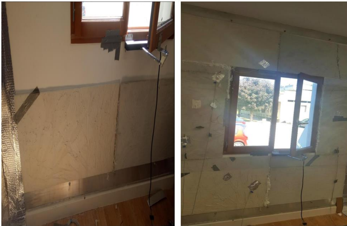
Figure III-74 : Mise en place et instrumentation du panneau TRC-15%MCP
