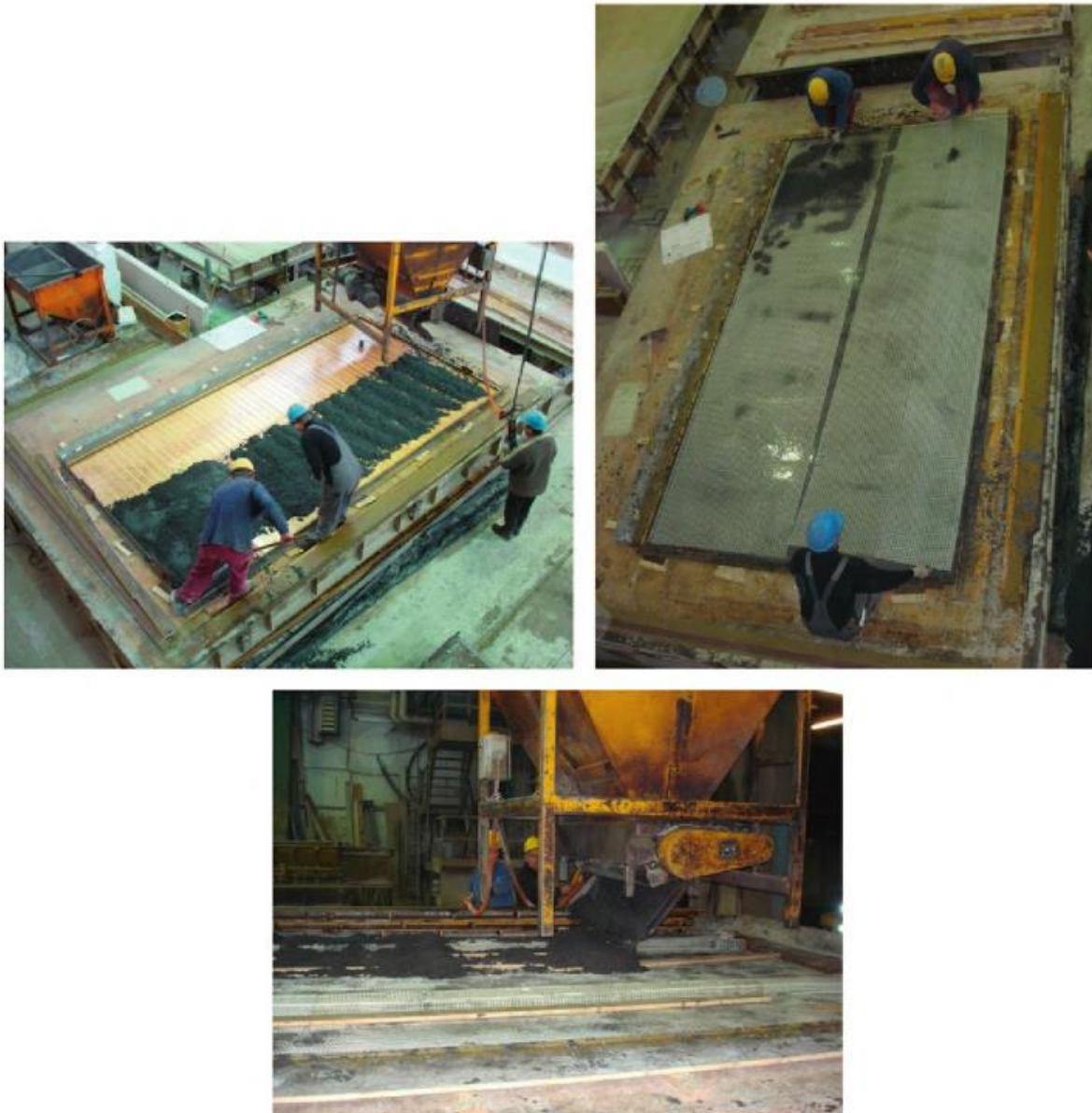
Figure II-22 Fabrication de panneaux de façades par la technique de stratification (Brameshuber et al.,2016)
