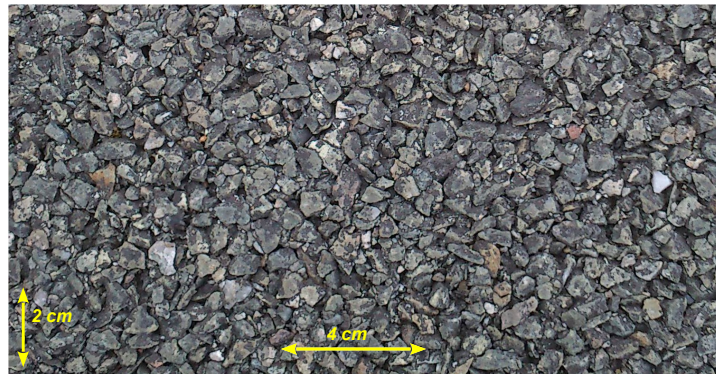
FIGURE 2.2 – Photographie du revêtement A .
