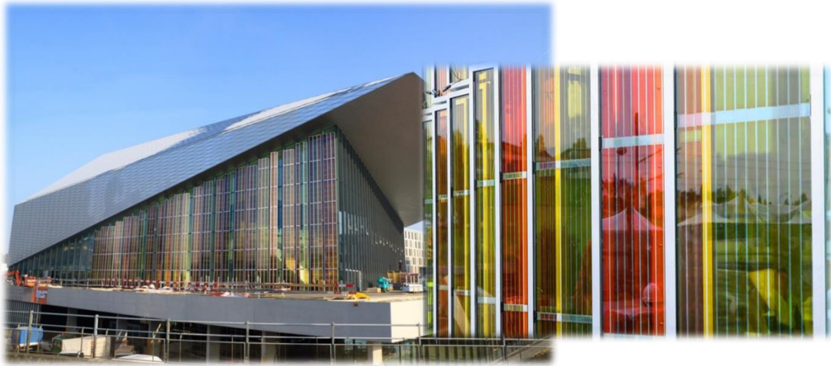
Figure 1 – Vue d'ensemble et zoom des panneaux photovoltaïques à base de cellules solaires à colorant intégrés à la façade de l'EPFL.
