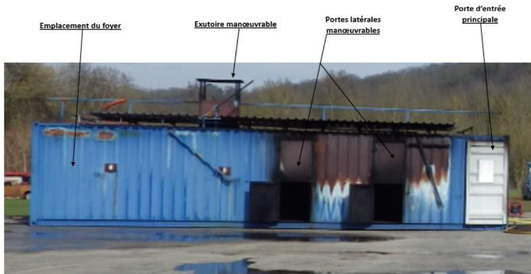
Figure 2. 5: Caisson d'entraînement des sapeurs-pompiers
