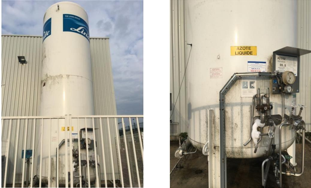
*Figure 12 : Réservoir de stockage de l'Azote à basse pression (CRITT-TJFU Bar le Duc)*
