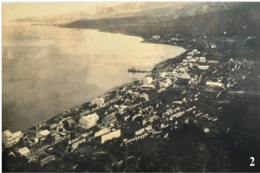
Figure 49 : Photographies de Saint-Pierre en reconstruction : n°1 : Vue générale de Saint-Pierre renaissant en 1926 et n°2 : La ville de Saint-Pierre en reconstruction en 1929 120
