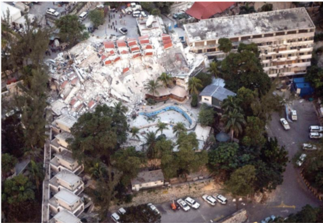
Figure 44 : Photographies du siège de la MINUSTAH de Port-au-Prince détruit après le séisme 111
