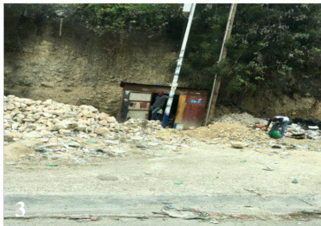
Figure 12 : Exemples de stigmates du séisme du 12 janvier 2010 dans les rues de Port-au-Prince : n°1 : Ruines de bâtiments dans une des rues près du palais présidentiel, 6 ans après ; n°2 : Exemple d'un ancien cinéma toujours en ruine en 2016 ; n°3 : Un homme devant les ruines de sa maison qui vit dans la case en tôle construite dans l'urgence 35
