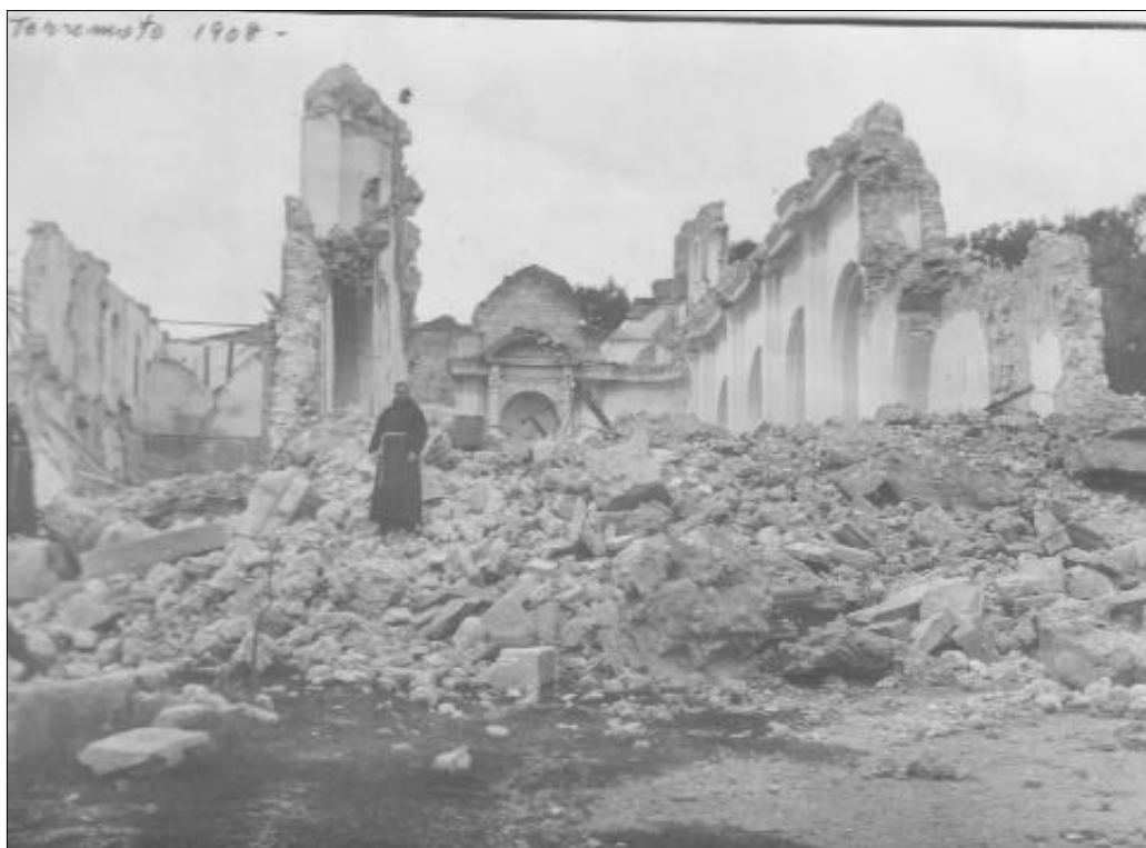
fig. 5. Un couvent de Messine détruit par le tremblement de terre de 1908.
