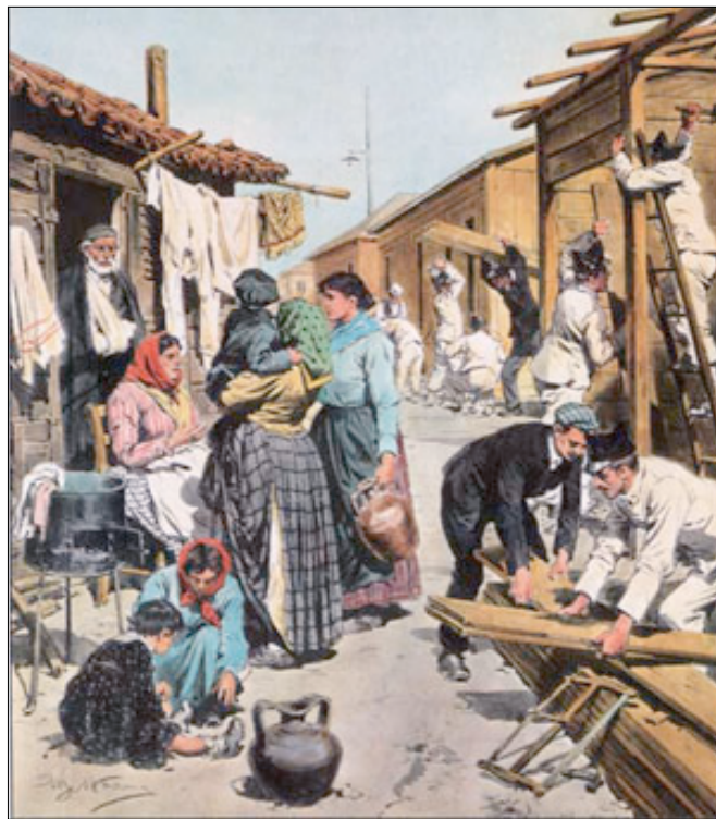
fig. 10. L'armée construit des baraques à Messine en 1908.
