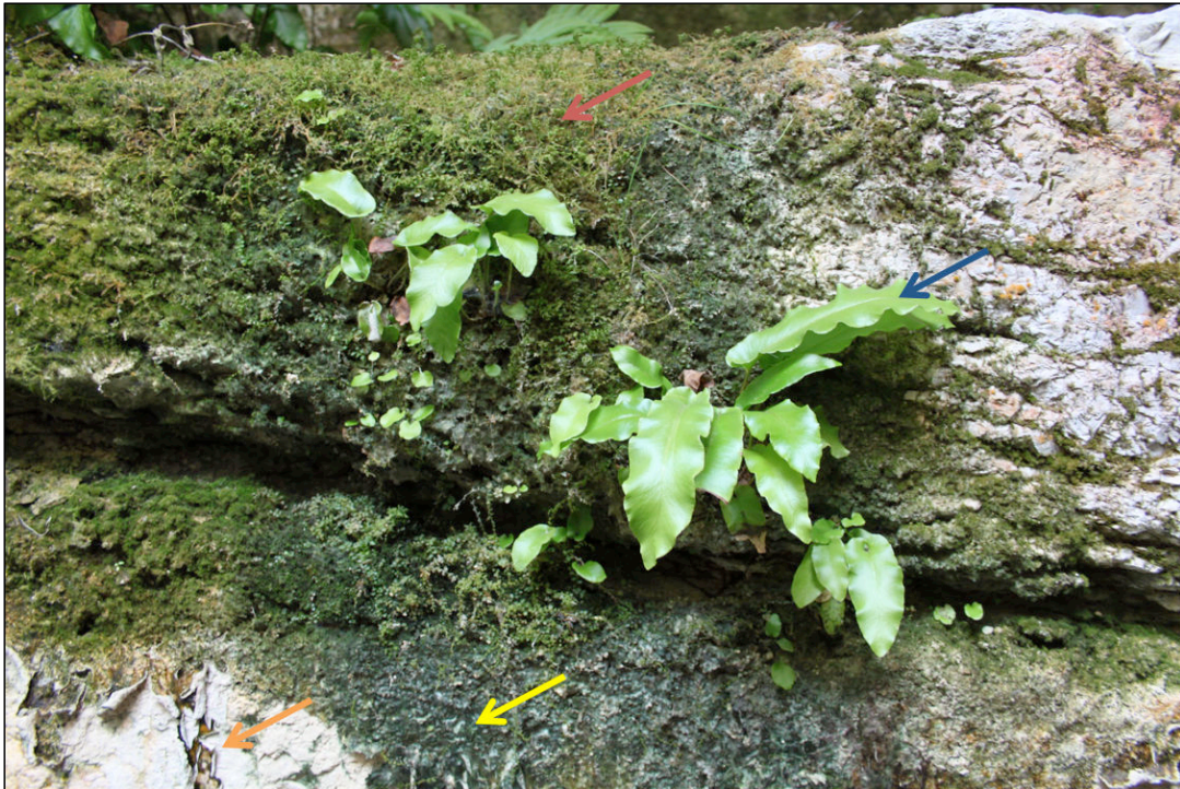
Figure 4 : Entrée de la grotte de Réclère (Suisse). La flore est composée de plantes supérieures (flèche bleue), de bryophytes (flèche rouge) et de micro-algues/cyanobactéries (flèche jaune). Les micro-organismes provoquent une biodétérioration du support colonisé (flèche orange).
