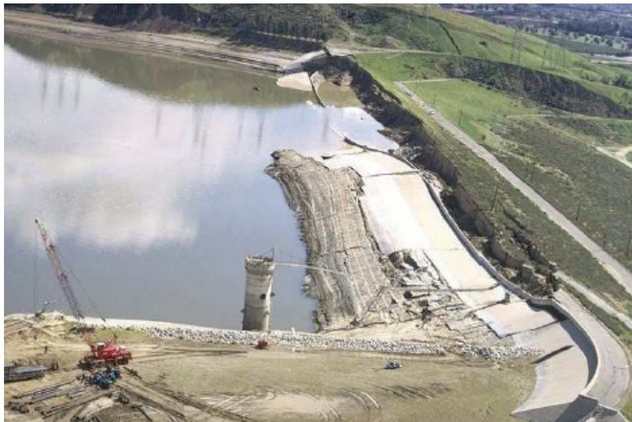
FIGURE 4 – Glissement du parement amont du barrage de Van Norman lors du séisme de San Fernando (1971).
