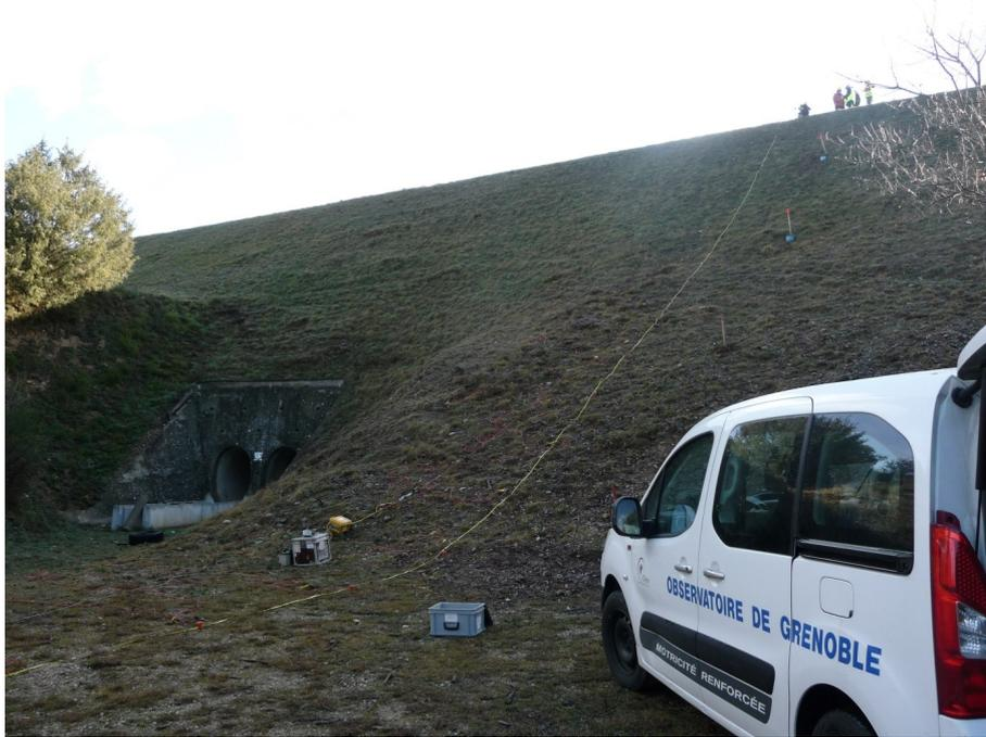
FIGURE 2.7 – Site C : photo du talus aval de la digue prise depuis le terrain naturel. Illustration du contexte à trois dimensions du site.
