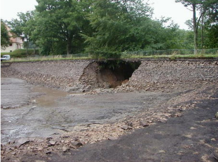
FIGURE 2 – Exemple de rupture par érosion.
