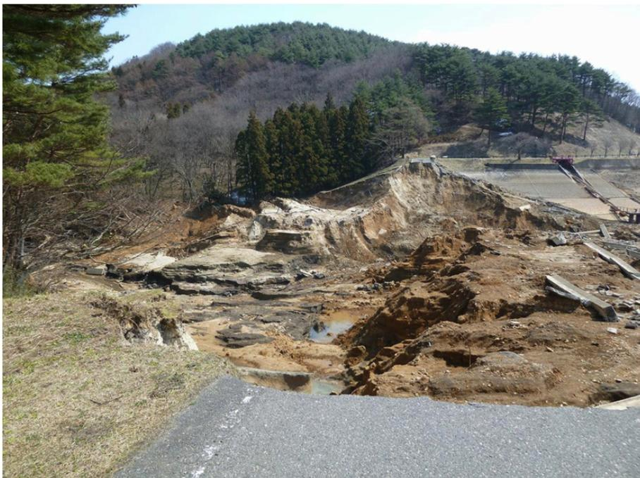
FIGURE 3 – Rupture du barrage du Fujinuma lors du séisme de Tohoku (2011).
