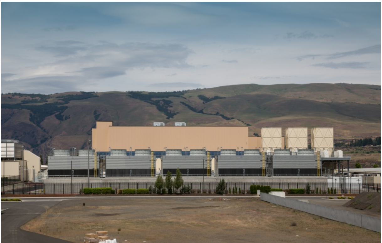
Figure 14. Un des centres de données que Google a construit en 2006 ( The Dalles ) 47
