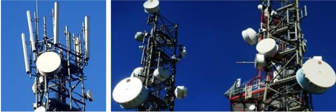
Figure 3 : Répéteurs hertziens utilisés dans les liaisons point à point des opérateurs [13].
