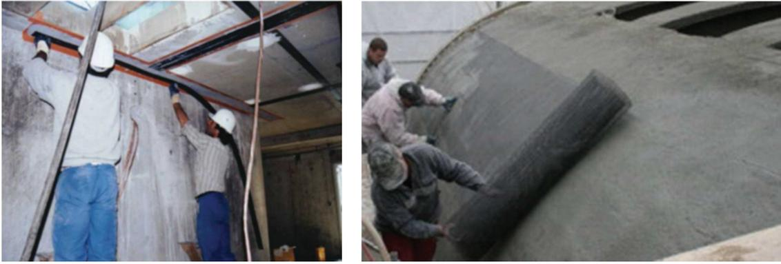
Figure I-2 : Renforcement par matériaux composites
