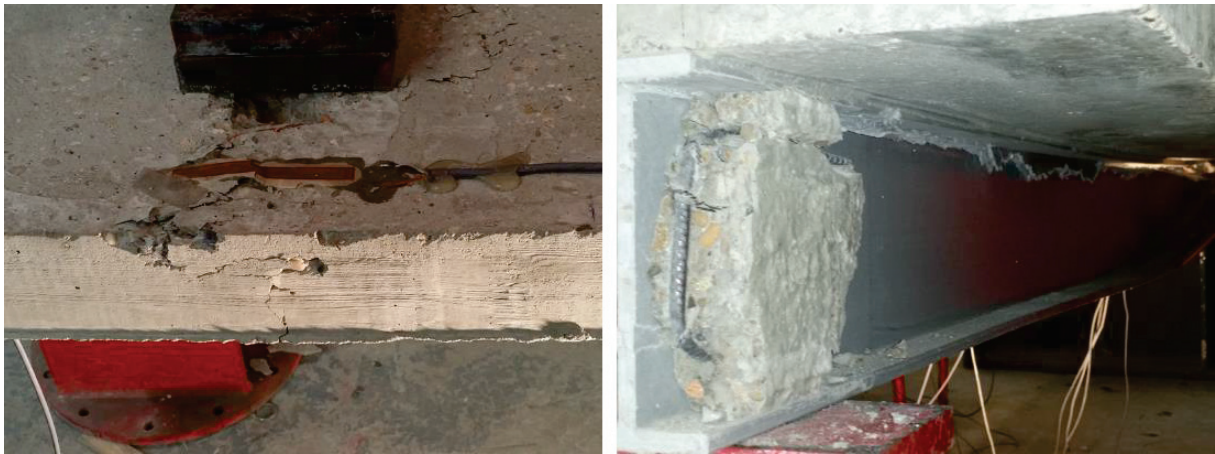
Figure IV-20 : Mode de ruine de la poutre PCB3
