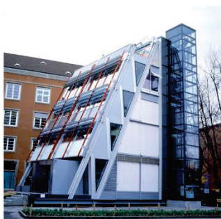
Eyecatcher building- Suisse Bâtiment de 5 étages construit des profilés pultrudés
