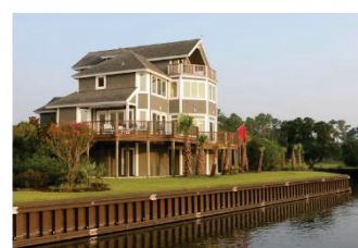
Mur de palplanches de GFRP
