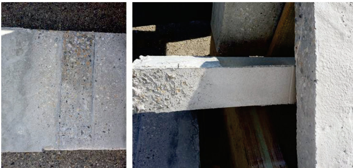
Figure IV-35 : Mode de ruine de la poutre PCB2
