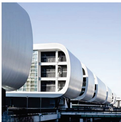
Sheraton Hotel – Milan, Italie Revêtement extérieur en composites FRP pultrudés
