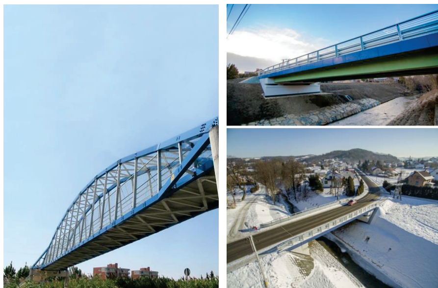
Figure I-6 : Exemples de ponts construits en GFRP : la passerelle de Lérida de longueur de 38 m construite en 2001 en Espagne (image à gauche), le premier pont routier construit en 2015 de 22 m de longueur en Pologne (images à droite)
