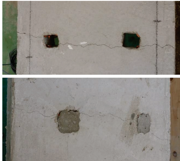
Figure IV-38 : Fissuration de la dalle du béton avant chargement pour les poutres PCB5 (photo en haut) et PCB4 (photo en bas)
