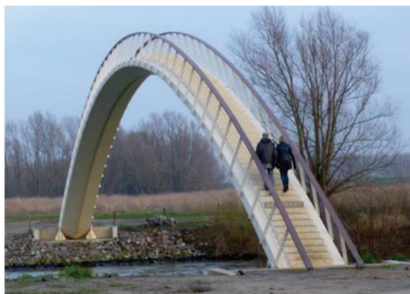
Passerelle de l'Ooypoort - Nimègue, Gueldre, Pays-Bas Passerelle pour piétons et pont en matériau composite GFRP
