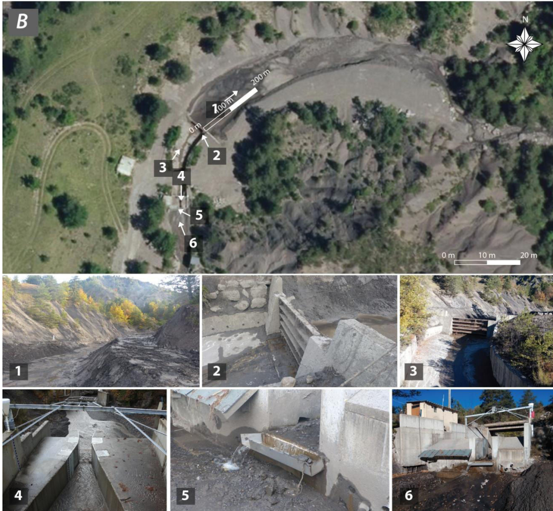
Figure 2.17 : Station de jaugeage des débits située à l'exutoire du bassin versant du Laval. A/ Composition du site de mesure (dans Mathys, 2006). B/ L'exutoire vu dans son ensemble. Les flèches blanches indiquent le sens de la prise de vue des photos 1 à 6.
