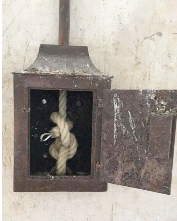
Figure 21. Intérieur d'une boîte de lanterne, hôtel des Invalides, Paris
