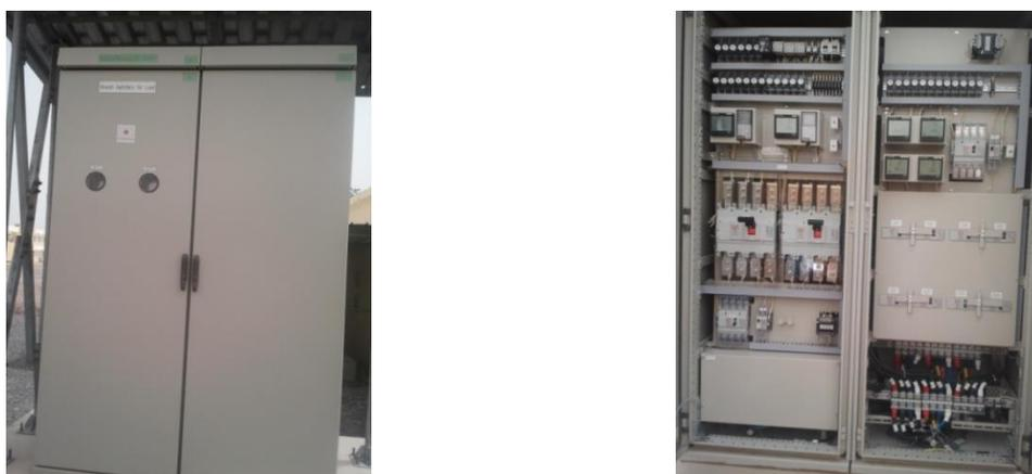
Figure 2.5 - Armoire de commutation des charges
