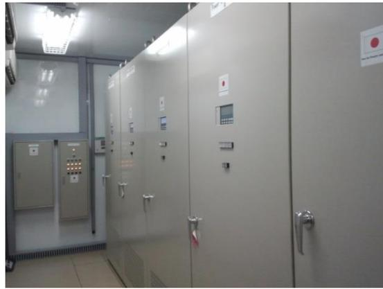
Figure 2.4 - Aperçu des armoires des onduleurs
